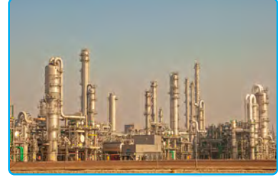
Görsel 2.1: Petrol rafinerisinde metal petrol ve gaz tankları
