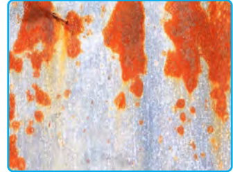
Görsel 1.19: Galvanik korozyon
