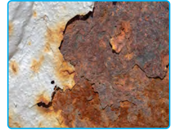
Görsel 1.23: Kabuk altı korozyonuna uğramış metal
