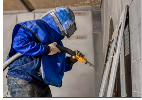
Görsel 1.58: Yüzey hazırlama işlemi
