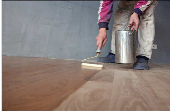
Görsel 8.15: Ahşap zemin üzerine sentetik reçine uygulaması
