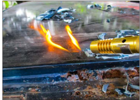
Görsel 1.61: Isıl raspalama yöntemi
