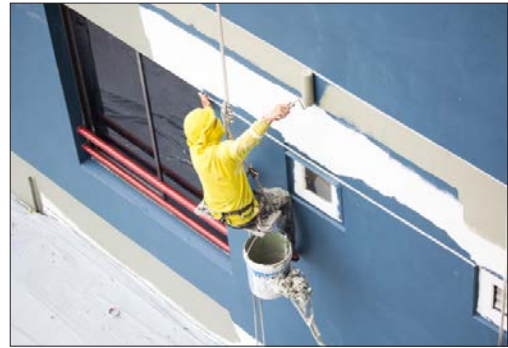
Görsel 8.2: Dış cephelerde silikonlu boya uygulaması
