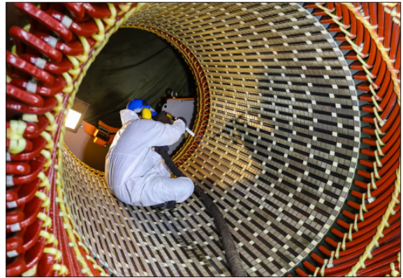
Görsel 2.6: Kuru buz ile temizleme uygulaması
