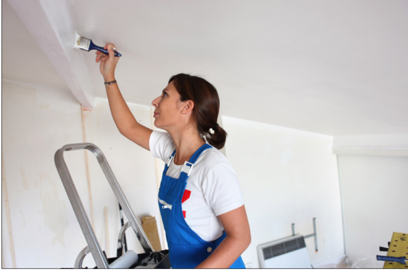
Görsel 8.7: Akrilik tavan boya uygulaması
