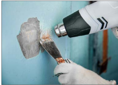
Görsel 2.9: Sıcak hava yöntemiyle temizlenen eski boya
