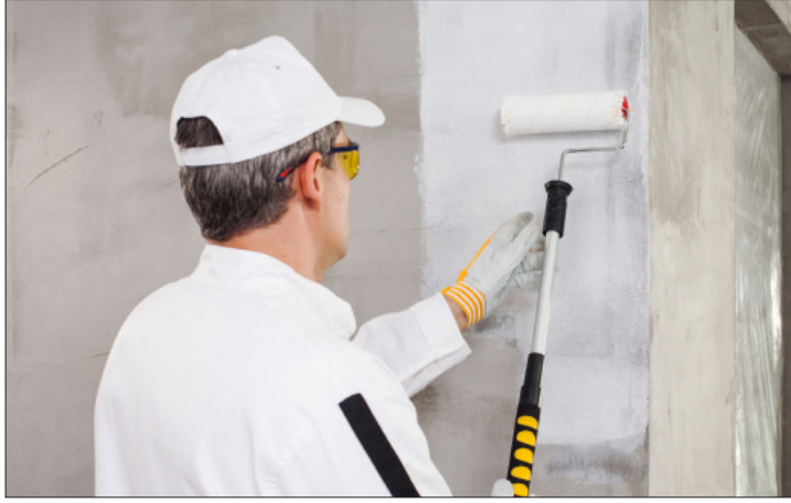
Görsel 3.1: Astar boya uygulanan dış cephe
