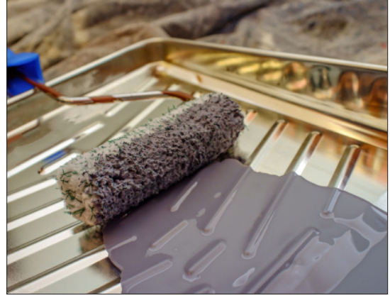
Görsel 6.8: Sıva yüzeye uygulamaya hazır akrilik astar
