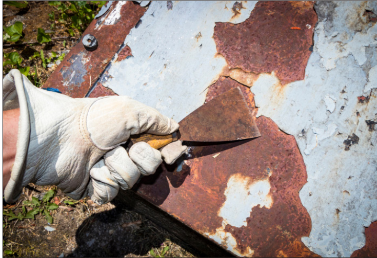
Görsel 2.1: Yüzeyden eski boya tabakasının uzaklaştırılması
