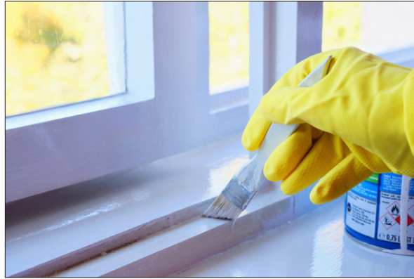
Görsel 8.19: Saten boya uygulaması
