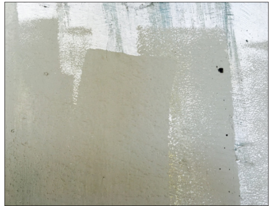
Görsel 6.10: Geçiş astarı ile eski yüzey renginin kapatılması
