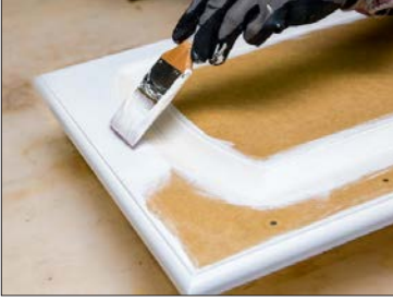
Görsel 6.3: Fırça ile astar uygulaması
