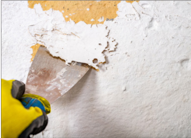
Görsel 1.63: Mekanik raspalama yöntemi
