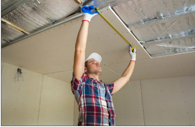
Görsel 2.21: Asma tavan olarak kullanılan alçıpan
