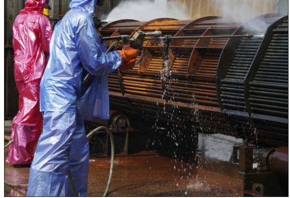
Görsel 2.5: Tabaka hâlindeki pasın su jetiyle temizlenmesi
