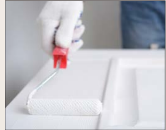
Görsel 6.22: Astar boyası uygulanan ahşap kapı
