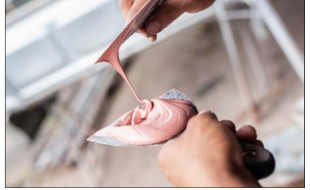
Görsel 5.4: Macun ve sertleştiricinin karıştırılması
