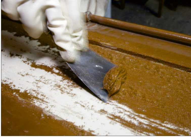
Görsel 1.62: Kimyasal raspalama yöntemi
