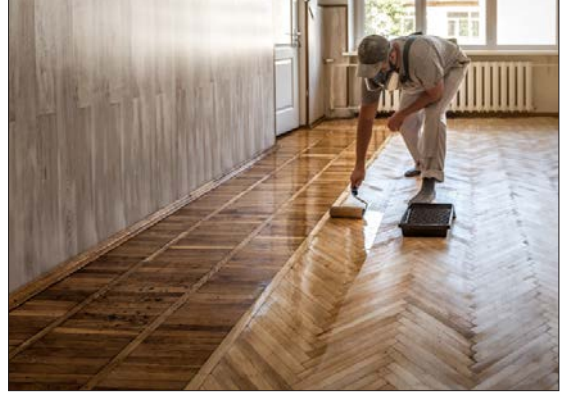
Görsel 9.1: Yer döşemelerinde kullanılan ahşap yüzey
