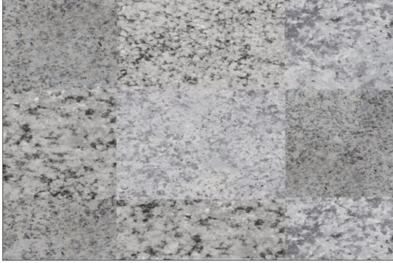
Görsel 2.18: Duvara granit yüzey uygulaması
