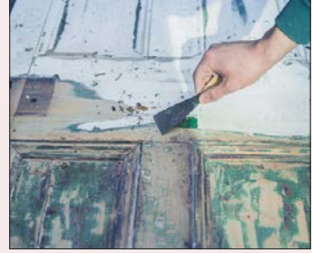
Görsel 6.20: Dolgu macunu uygulanan ahşap kapı
