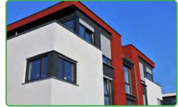
Görsel 1.14: Bina dış cephesinde uygulanmış emülsiyon boya
