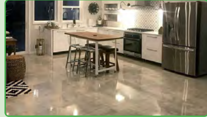
Görsel 6.14: Epoksi cila uygulanmış mutfak zemini
