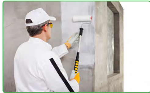
Görsel 5.7: Yüzeyin astar boya ile hazırlanması
