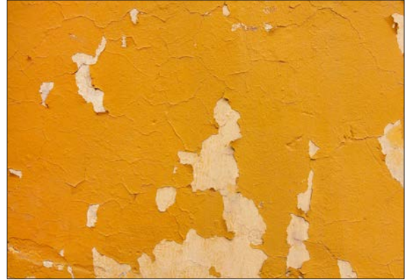
Görsel 3.12: Yapışma zayıflığı kusuruna sahip boyalı yüzey
