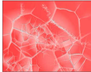
Görsel 3.18: Çatlama kusuruna sahip boyalı yüzey
