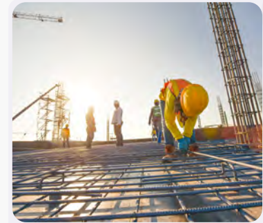
Görsel 9.5: İnşaat demiri kullanımı
