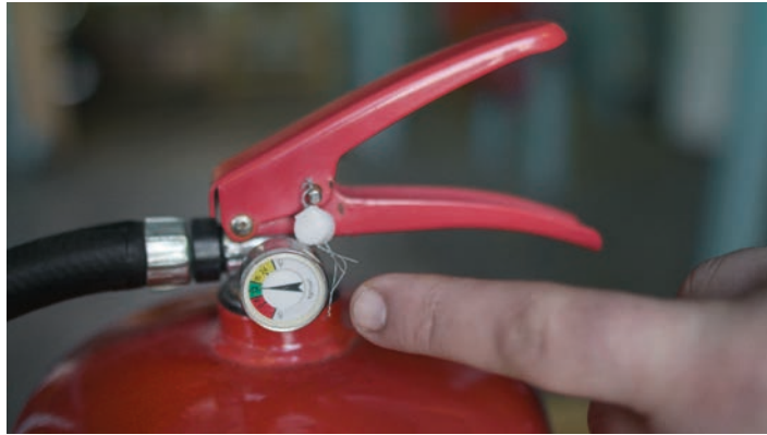
Görsel 2.37: Kuru kimyevi tozun manometresinin bulunması gereken basınç aralığı
