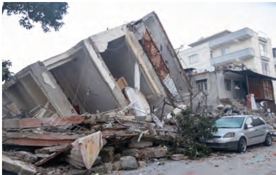
Görsel 1.45: Çapraz (merdiven) şeklinde yıkılan bina
