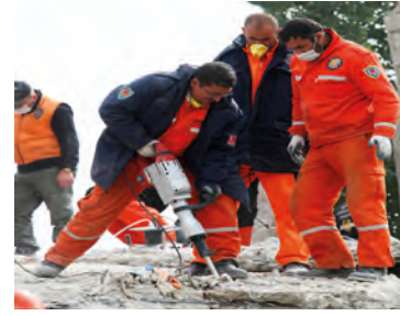
Görsel 4.37: Beton kırıcı matkap uygulaması
