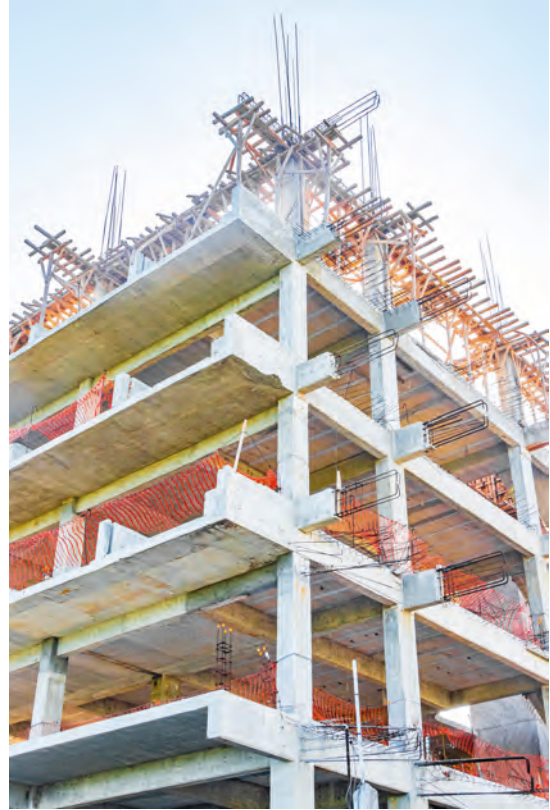
Görsel 1.40: Betonarme bina taşıyıcı unsurları
