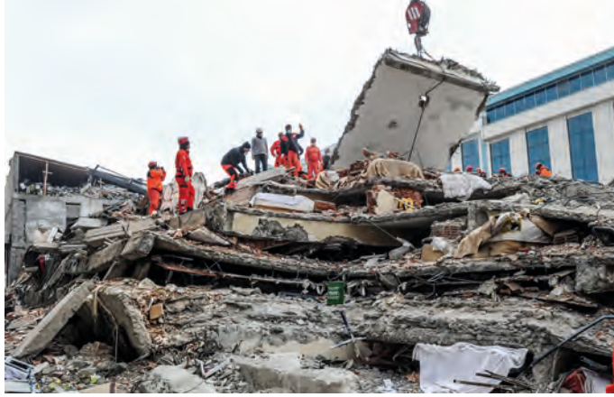
Görsel 1.44: Pres şeklinde yıkılan bina
