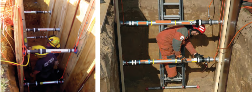
Görsel 4.27: Hidrolik silindir (ram) uygulaması
