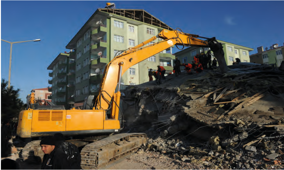
Görsel 4.36: Enkazın kısmi olarak kaldırılması
