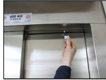
Görsel 8.22: Asansör kapısının açılması
