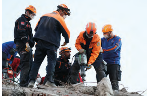
Görsel 4.18: Enkaz üzerinde beton kırma işlemi
