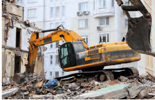
Görsel 4.3: Enkaz yıkım çalışması
