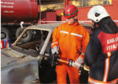
Kapı açma ve tavanı gövdeye bağlayan tüm direklerin kesilmesinden sonra tavan komple çıkarılabilir.
