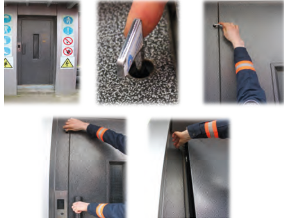
Görsel 8.14: Asansör kapısının anahtarla açılması
