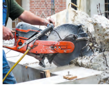
Görsel 4.15: Beton kesme uygulaması
