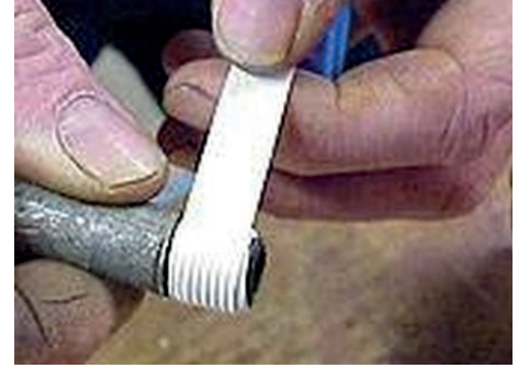
Görsel 11.19: Teflon bant sarılması
