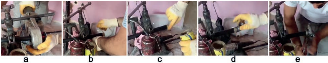
Görsel 11.21: Borunun eklenmesi işlem basamakları
