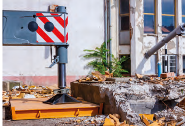
Görsel 4.5: Denge ayaklarının desteklenmesi
