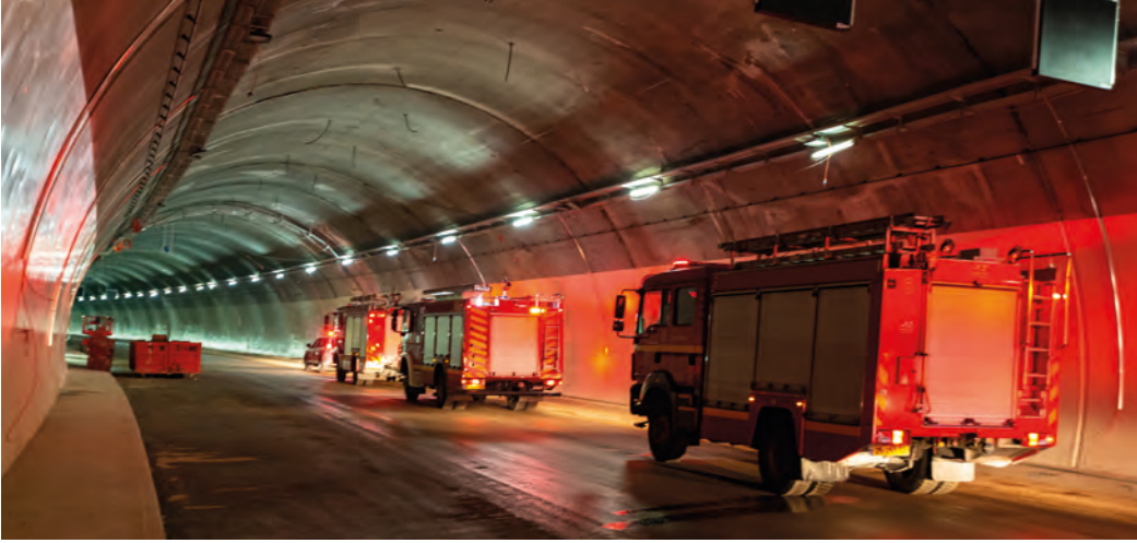
Görsel 8.22: Tünel yangını
