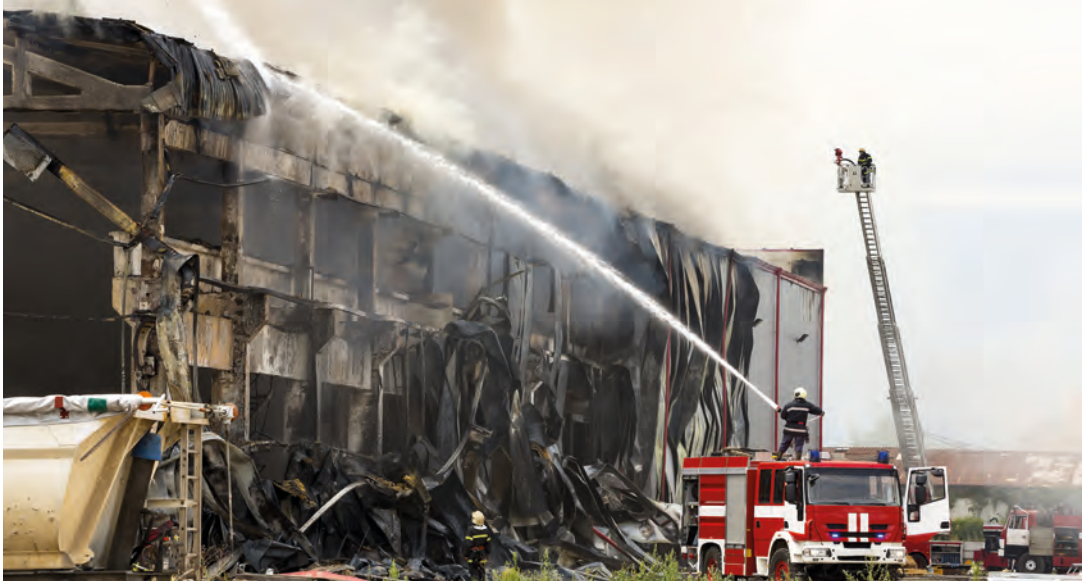
Görsel 9.19: Fabrika yangınında soğutma işlemi
