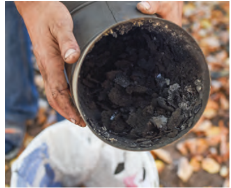
Görsel 8.2: Bacanın içinde oluşan kreozotun görüntüsü
