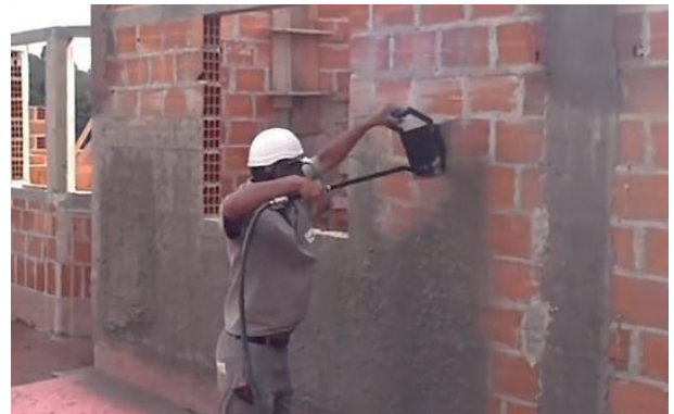
Resim 5.14: Makine ile siva
