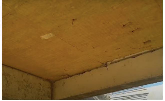
Resim 7.8: Bina döşemeler arası yalıtım
