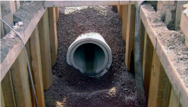
Resim 1.10: Dairesel kesitli beton bük künk borularla kanalizasyon inşası
