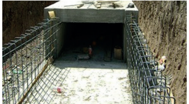
Resim 1.11: Betonarme dikdörtgen kesitli kanalizasyon inşası
