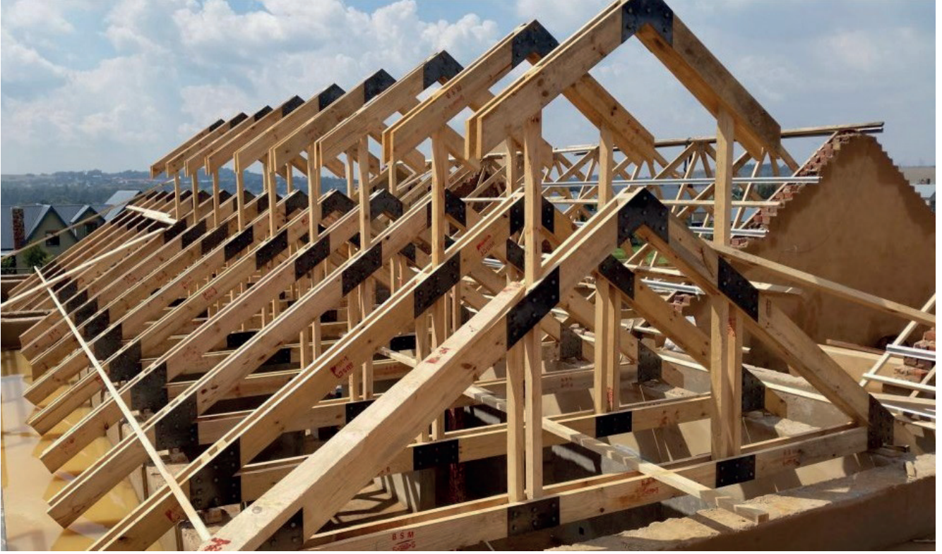
Resim 1.16: Ahşap askılı çatı makasları ve yerleşimleri
