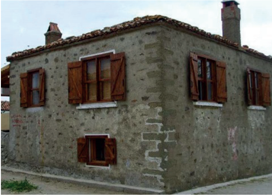
Resim 1.3: Köşe kilit taşı kâgir yığma yapı
