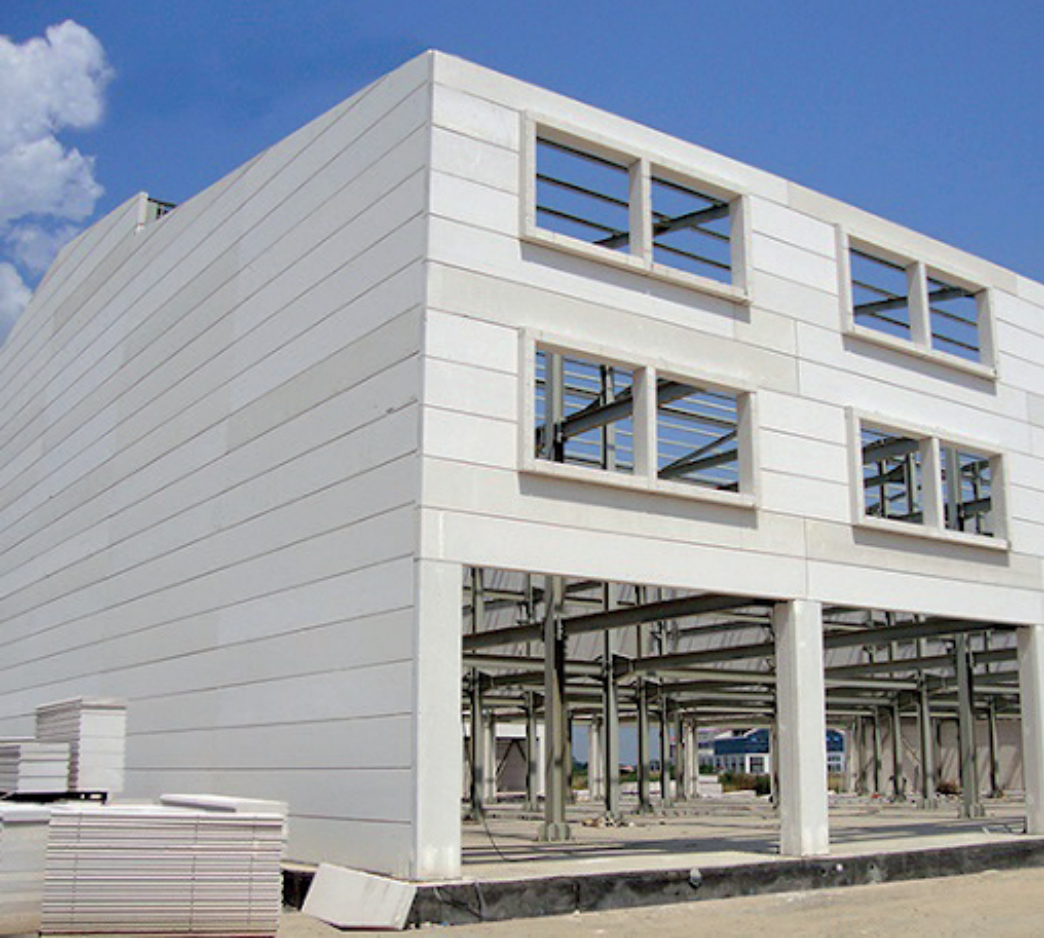
Resim 1.13: Yatay taşıyıcı panel gazbeton duvar sistemi
