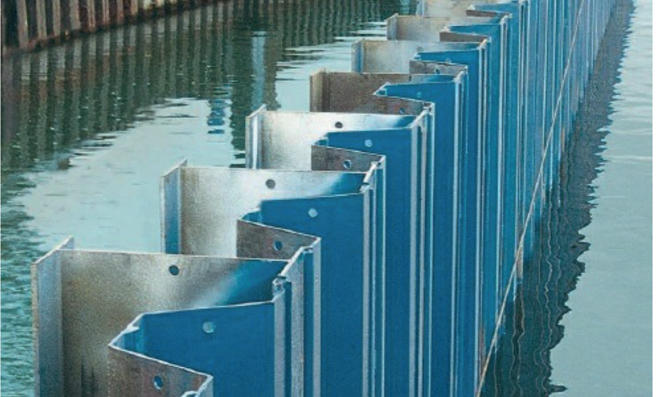
Resim 2.5: Çelik palplanş ile suyun engellenmesi uygulaması
