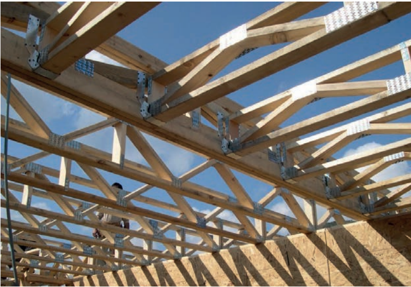
Resim 1.17: Ahşap askılı çatı birleşimleri
