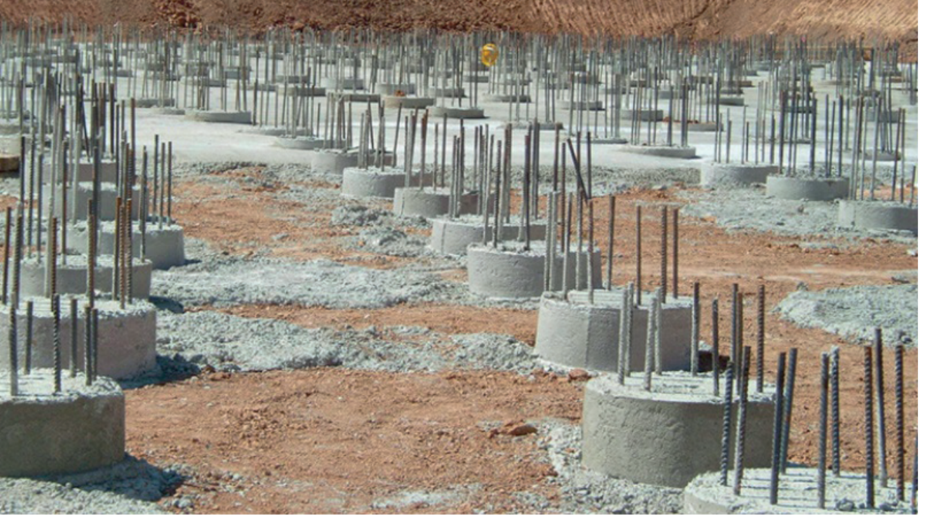
Resim 2.3: Betonarme fore kazık uygulaması
