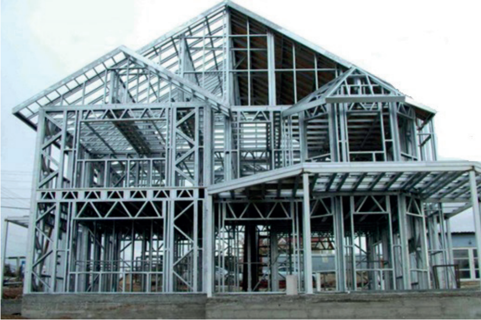
Resim 1.8: Çelik yapı (iş merkezi, çalışma ofisi) kaba inşaatı
