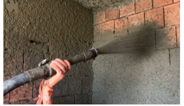
Resim 5.8: Püskürtme sıva
