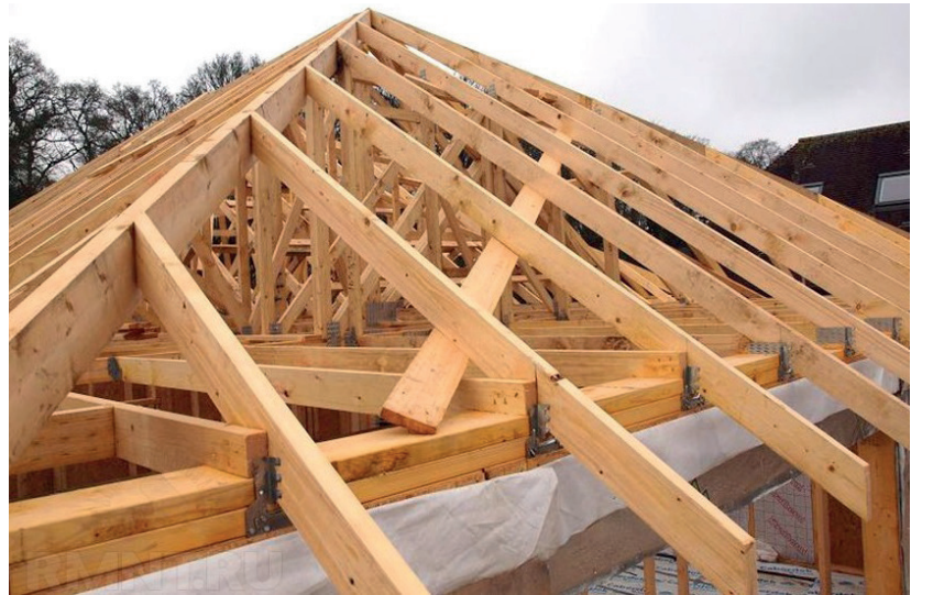
Resim 1.15: Ahşap oturtma çatı makasları ve birleşimleri
