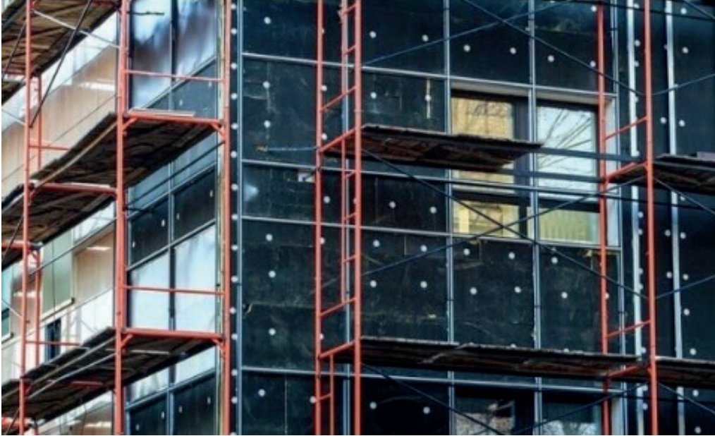
Resim 7.4: Bina dış yalıtımı
