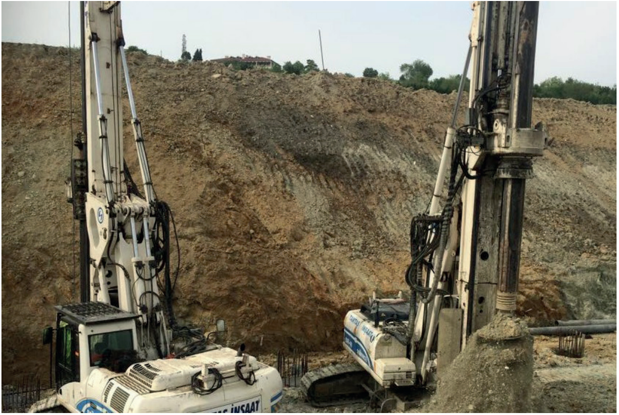
Resim 2.2: Fore kazık kuyusu açma çalışması
