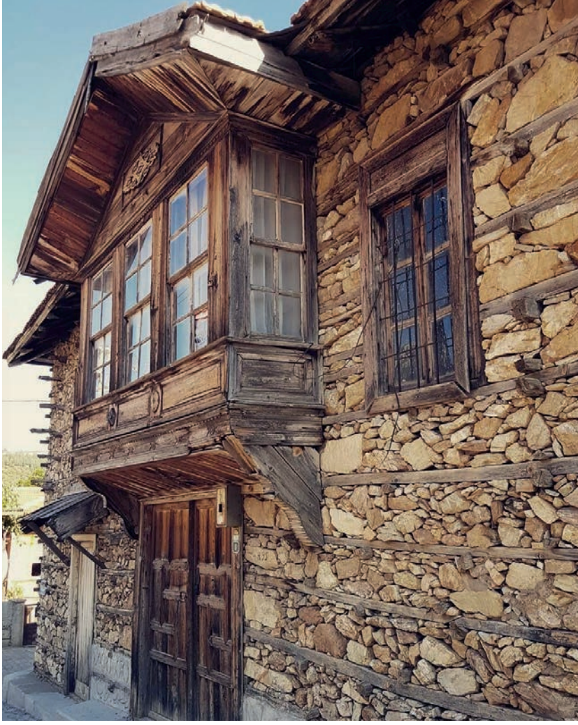
Resim 1.2: Ahşap ve doğal taş malzeme ile inşa edilen kâgir yığma yapı
