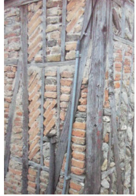
Resim 1.1: Yığma yapı tuğla dolgulu himiş duvar
