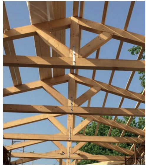
Resim 1.18: Ahşap çatı makasları ve elemanları birleşimi
