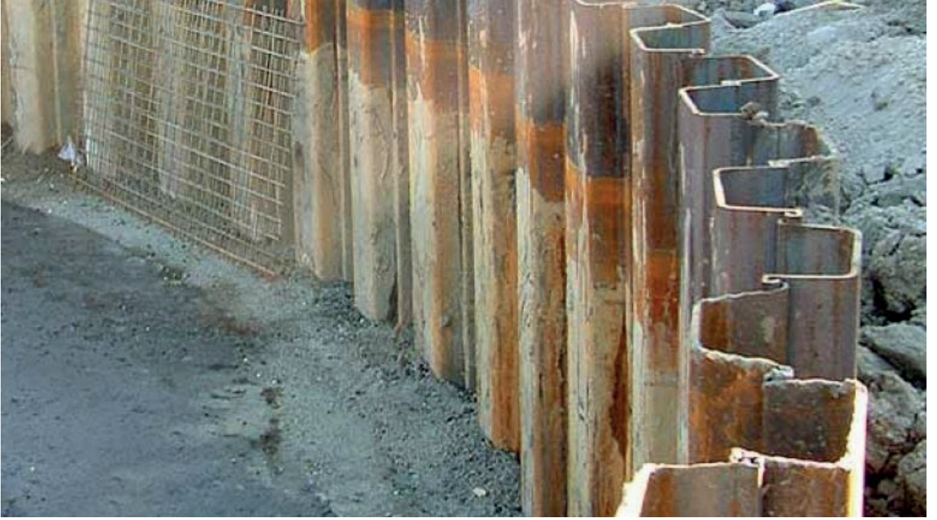
Resim 2.6: Çelik palplanş sistemi uygulaması
