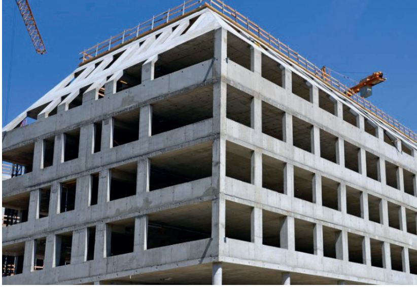
Resim 1.6: Betonarme çok katlı yapı (iş merkezi) kaba inşaatı
