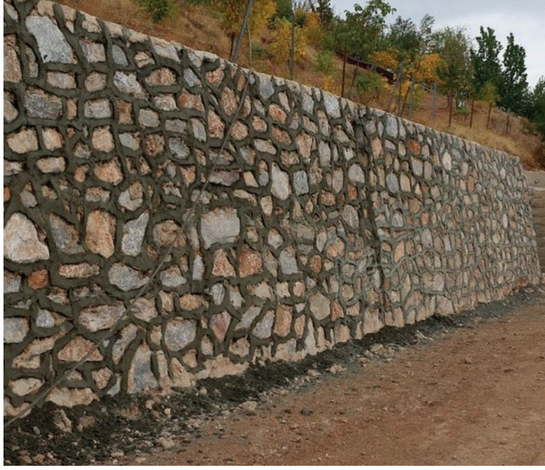
Resim 1.19: Taş istinad duvarı
