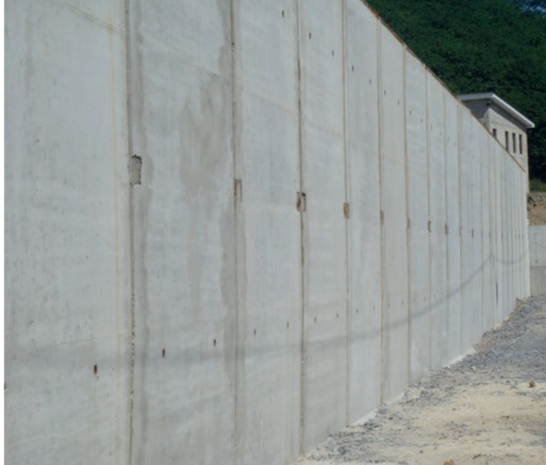
Resim 1.20: Betonarme istinad duvarı
