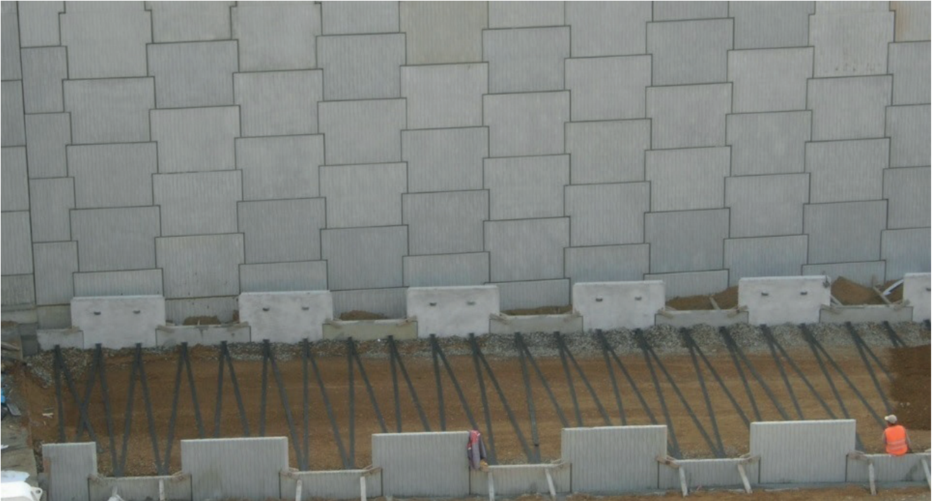
Resim 1.22: Toprakarme istinad duvarı
