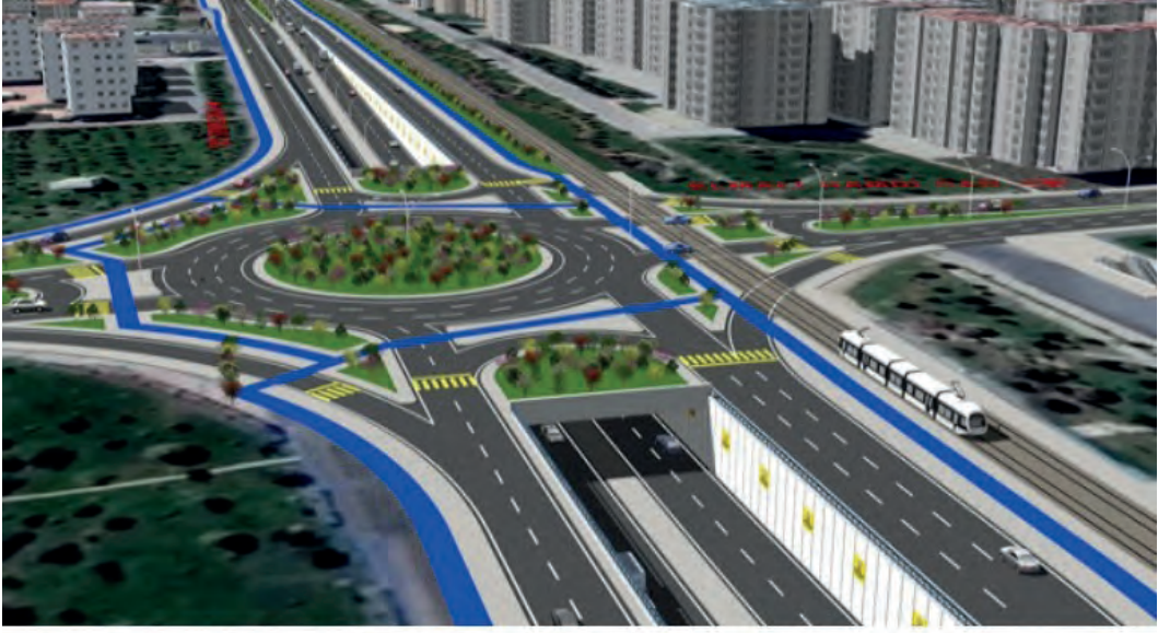
Şekil 2.24: Dönel köprülü kavşak (yaya üst geçitli)
