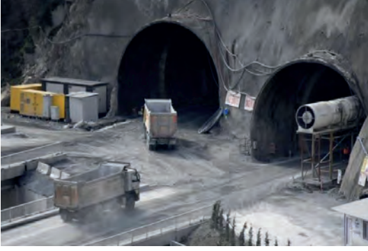
Resim 1.21: Gidiş ve geliş ayrı planlanan tünel inşa çalışması
