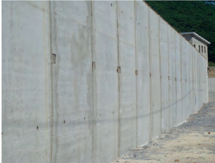
Resim 1.26: Betonarme istinad duvarı
