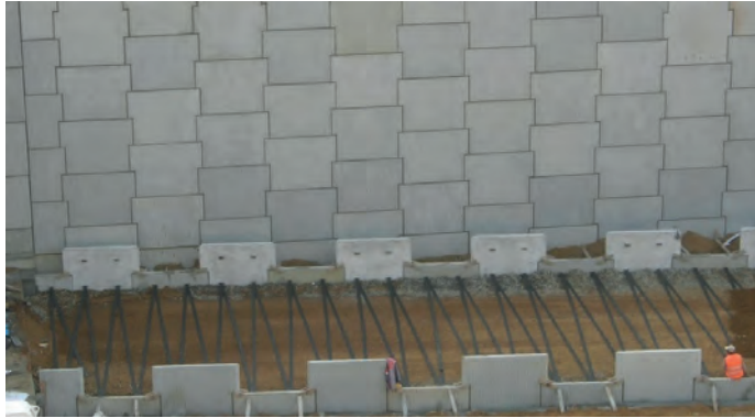
Resim 1.24: Toprakarme istinad duvarı
