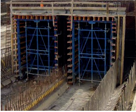
Resim 1.17: İki gözlü betonarme kutu menfez kalıp sistemi
