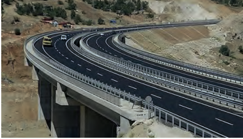
Resim 1.13: Karayolu orta açıklıklı köprü viyadük
