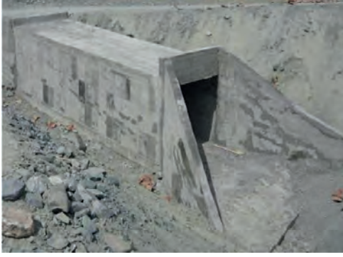
Resim 1.15: Tek gözlü betonarme kutu menfez
