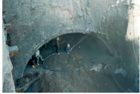
Resim 1.22: Tünel püskürtme beton çalışması örneği
