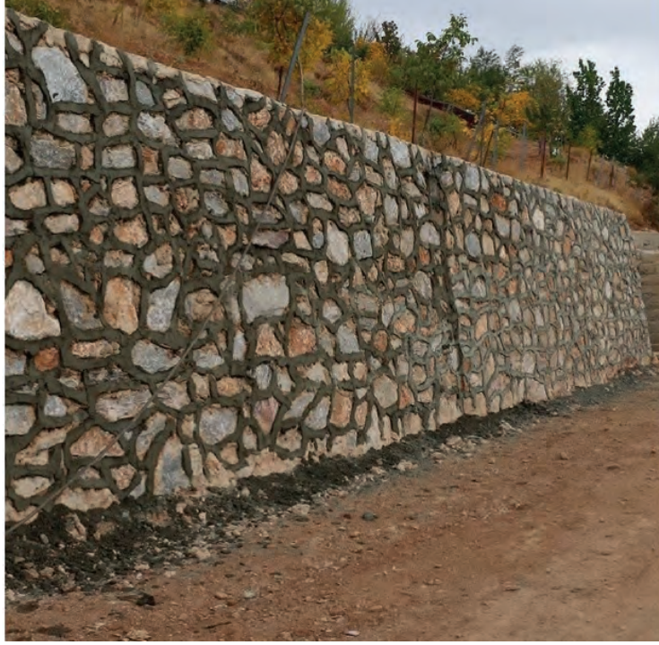
Resim 1.25: Taş istinad duvarı
