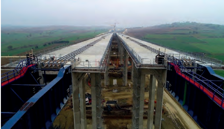
Resim 1.12: 1915 Çanakkale Köprüsü ve Otoyolu Projesi inşa çalışması
