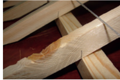
Resim 10.37: Çatı makasları arası ip kotu
