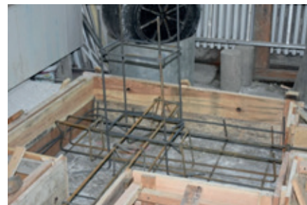
Resim 14.15: T1 temel donatı kontrolü
