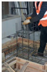
Resim 14.14: Kolon filiz ve etriyelerini bağlanması
