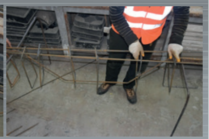
Resim 12.9: Etriyelerin yerlerine dizilmesi
