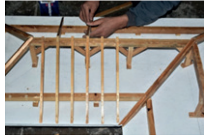
Resim 10.35: Merteklerin kertilmesi
