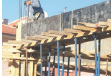
Resim 8.11: Kalıp kanat sökümü
