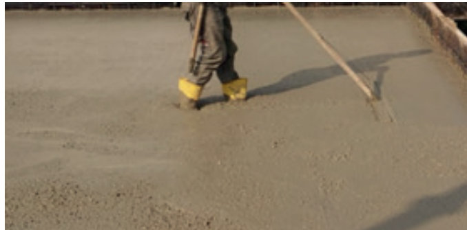
Resim 7.5: Yüzey düzeltme işlemi
