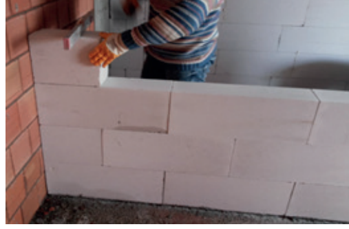
Resim 19.15: Duvarda su terazisi ile kontrollerin yapılması
