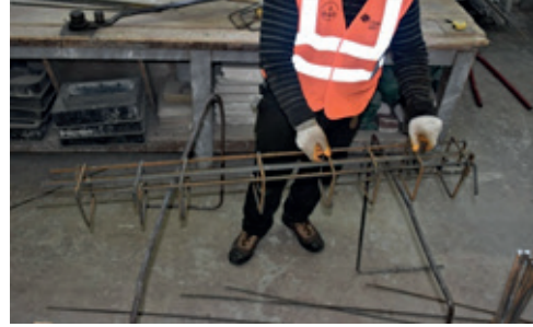
Resim 13.8: Etriyelerin dizilmesi
