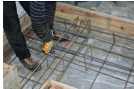
Resim 14.24: Hatlı etriyesi ve kolon filizi etriyesi baęlama
