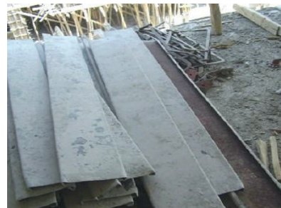
Resim 8.20: Döşeme kalıbı malzeme istifi
