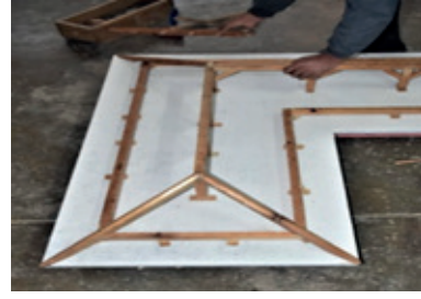
Resim 10.33: Eğik/dere mahyaların çakılması
