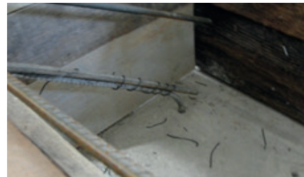
Resim 16.27: Merdiven demirlerinin bağlantılarını kontrol etme
