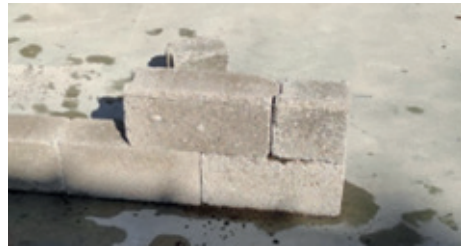
Resim 19.6: İkinci sıra uygulamasına yarım blok ile başlanması
