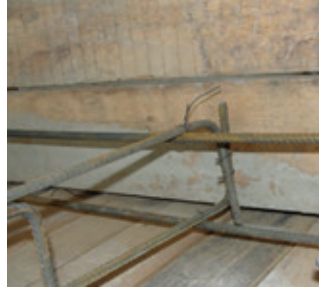
Resim 16.24: Alt ve üst tevezileri bağlama
