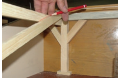
Resim 10.18: Mertek boyunun kesilmesi
