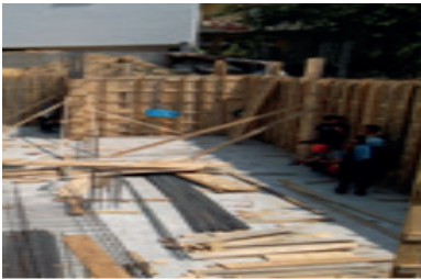
Resim 8.3: Çaprazların sökümü
