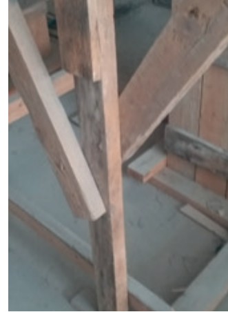
Resim 8.22: Takviyelerin sökülmesi
