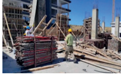
Resim 8.6: İskele boru dikmelerinin istifi
