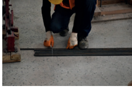
Resim 13.1: Demir çubuk markalama
