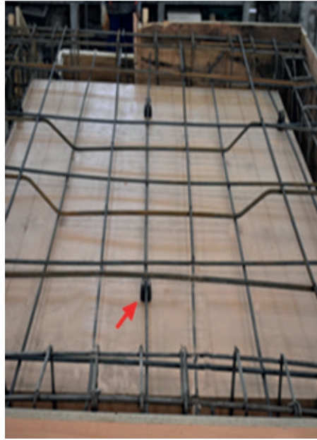
Resim 15.5: Tamamlanmış tek yönlü (hurdi) döşeme donatısı
