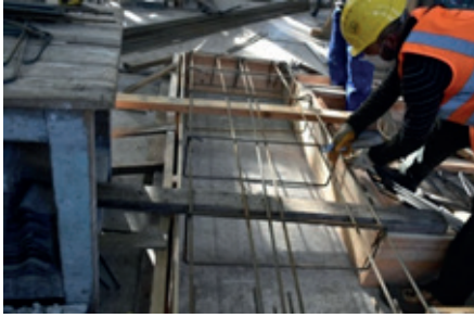
Resim 14.21: Demirleri markalı yerden baęlama
