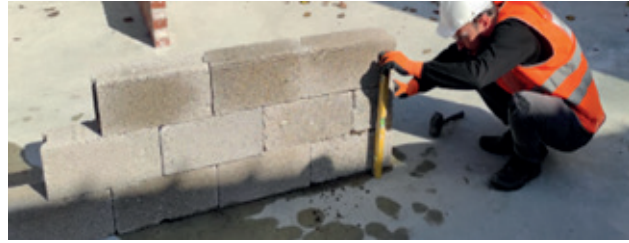
Resim 19.8: Şakul ve su terazisi ile yatay ve düşeylik kontrolü
