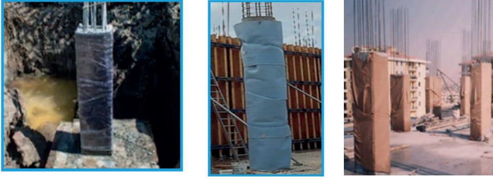
Resim 7.8: Kolon yüzeylerinin keçe, battaniye vb. sarılarak kür yapılması
