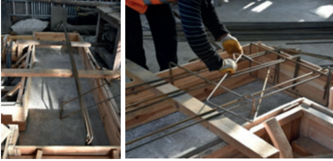
Resim 14.19: Kalıp içine demirleri serme
