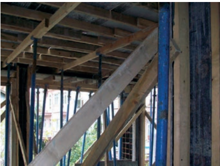
Resim 8.29: Metal dikmeler ve ahşap kalıp kirişleri
