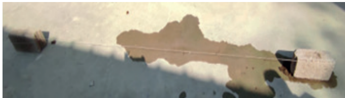
Resim 19.1: Köşe bloklarının yerleştirilmesi ve ip çekilmesi
