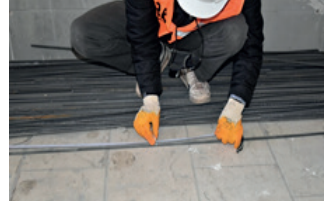
Resim 11.19: Demir çubuk markalama
