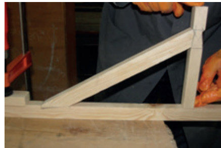
Resim 10.50: Bırakma kirişi, dikme ve eğik elemanları alıştırma
