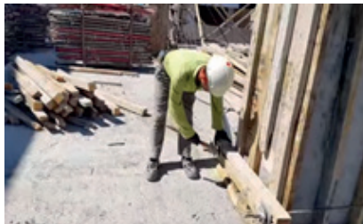
Resim 8.8: Tayrotların sökümü
