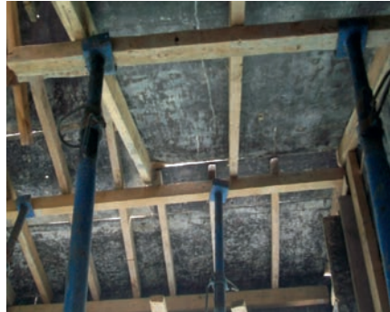
Resim 8.30: Karma kalıp takviyesi
