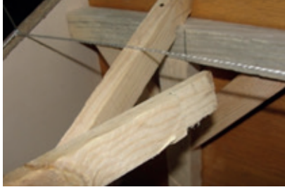
Resim 10.15: Kuşığın dikmeye alıştırılması
