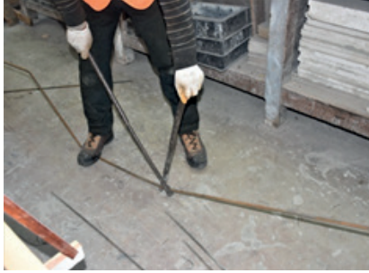
Resim 12.5: Bükme anahtarları ile pilye yapımı
