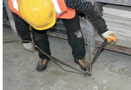
Resim 12.6: Pilye kıvrımının yapılması
