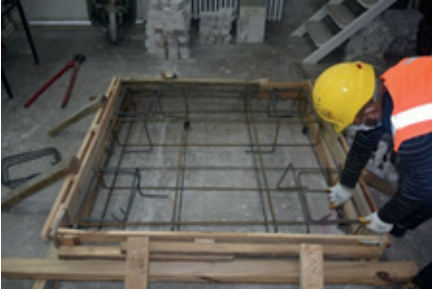
Resim 14.35: Kolon filiz etriyesi bağlama
