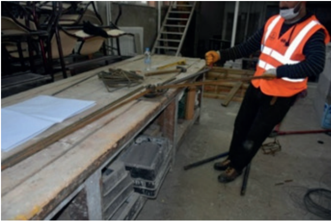
Resim 14.18: Markalama yapma ve bükme
