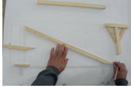
Resim 10.2: Çatı elemanları hazırlığı
