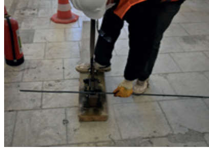
Resim 11.26: Pilye demir çubuğu kesme
