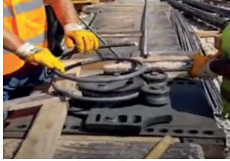
Resim 11.34: Makinede fret donatısının bükülmesi
