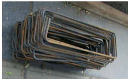
Resim 12.4: Bükülmüş etriyeler
