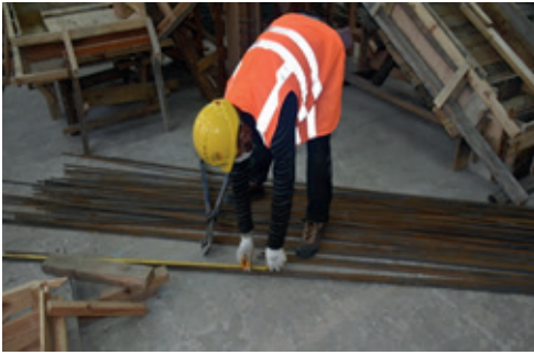
Resim 13.12: Perde donatılarının markalanması
