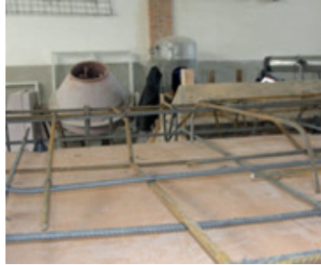
Resim 16.25: Boyuna üst demirleri bağlama
