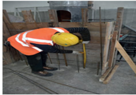
Resim 13.17: Tevzi demir aralıklarının markalanması
