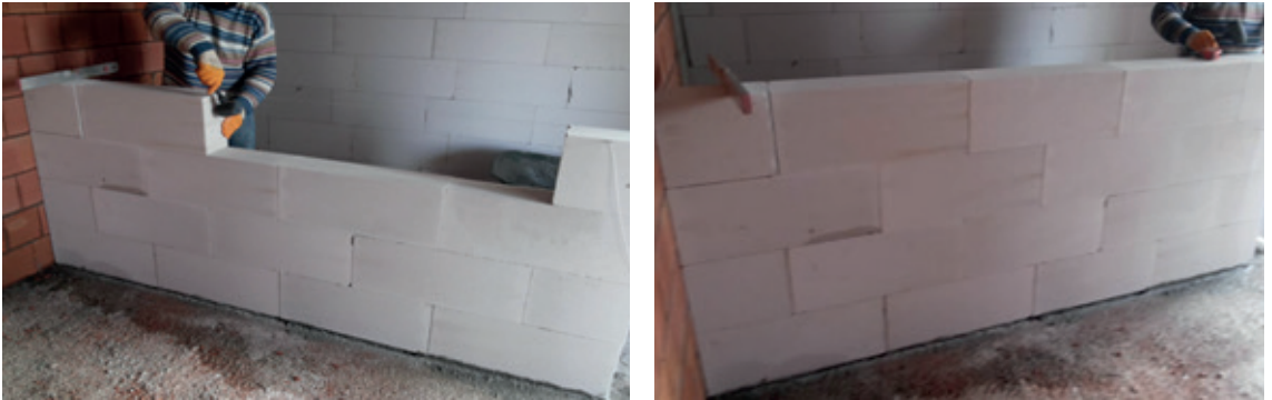
Resim 19.14: Diğer sıraların duvar örgü kurallarına göre tamamlanması
