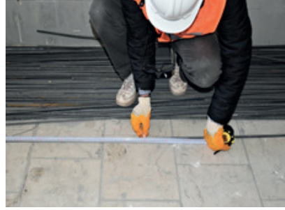
Resim 11.25: Pilye demir çubuğu markalama
