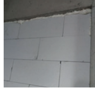
Resim 19.16: Duvar ile kolon/perde birleşim yerindeki boşluğun dolgu malzemesi ile doldurulması
