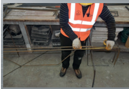
Resim 12.7: Etriye aralıklarının markalanması
