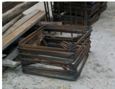
Resim 13.5: Bükülmüş etriyeler
