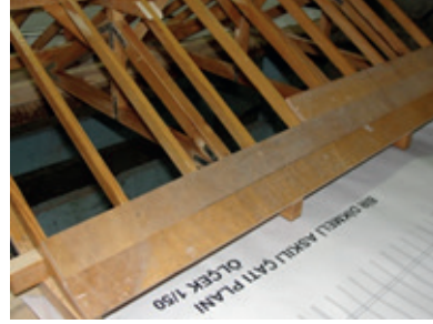
Resim 10.76: Kaplama tahtalarının çivilenmesi
