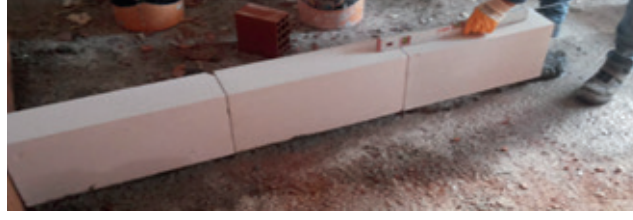
Resim 19.11: İlk sıra yataylık kontrollerinin yapılması
