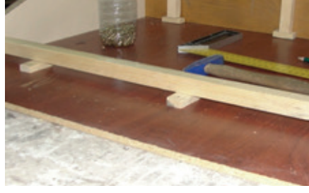
Resim 10.8: Dikme yastıklarının çakılması
