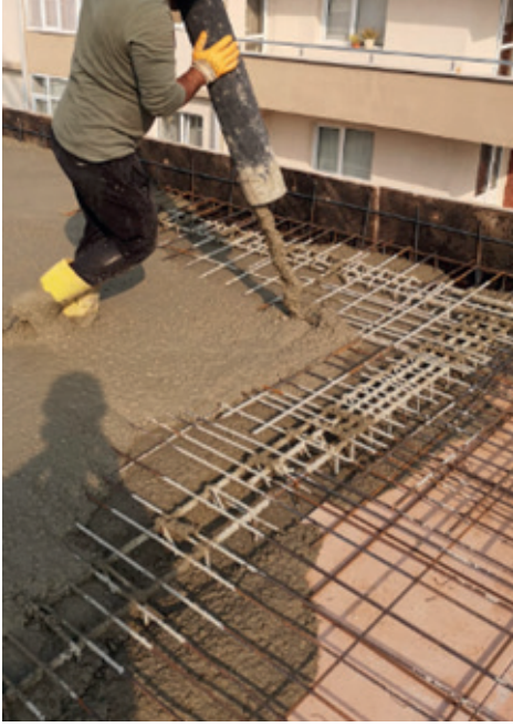
Resim 7.1: Betonun dökülmesi işlemi
