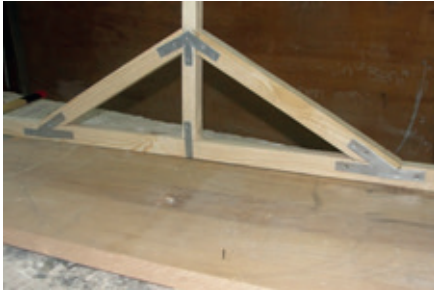
Resim 10.55: Metal bağlantıların tamamlanması
