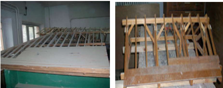
Resim 9.3: Çatının ahşap ile kaplanması
