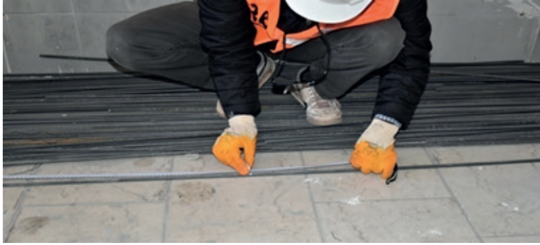
Resim 11.30: Fret donatısı markalama
