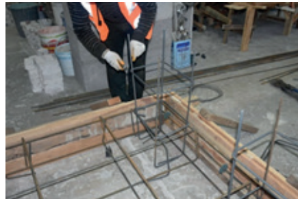
Resim 14.38: Kolon filiz ikinci etriye bağlama
