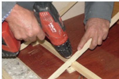
Resim 10.36: Merteklerin çivilenmesi
