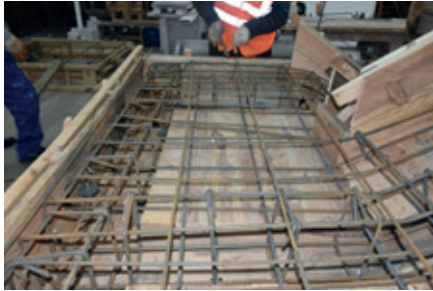
Resim 16.15.b: Donatı bağlama yerlerinin projeye uygunluğunun kontrol edilmesi
