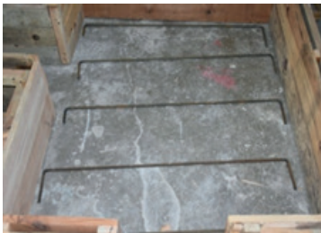
Resim 14.6: Demirlerin kalıba serilmesi
