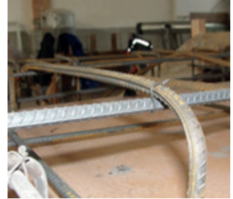
Resim 16.24: Alt ve üst tevezileri bağlama
