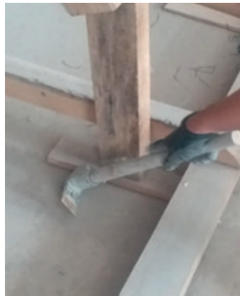
Resim 8.23: Dikme altındaki yastıkların alınması
