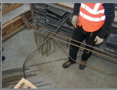
Resim 12.8: Etriyelerin takılması
