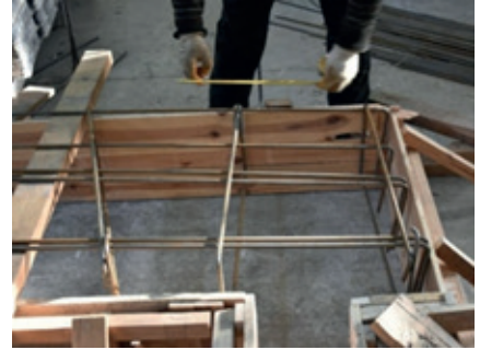
Resim 14.20: Baęlama yerlerinin markalanması
