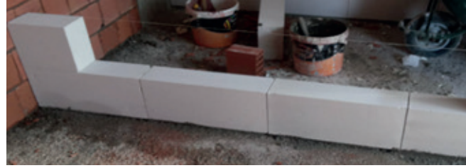
Resim 19.12: Yarım blok ile ikinci sraya başlanması
