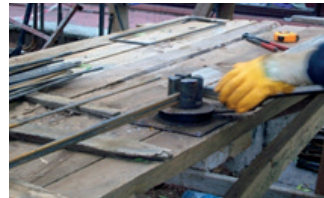
Resim 11.21: Etriye bükme tezgahına yerleşimi
