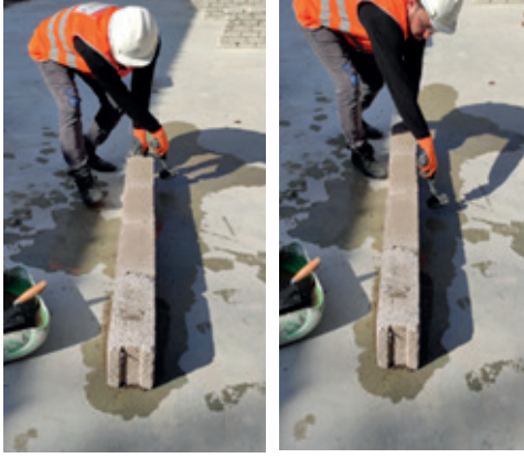
Resim 19.2: İlk sıra uygulamasının yapılması
