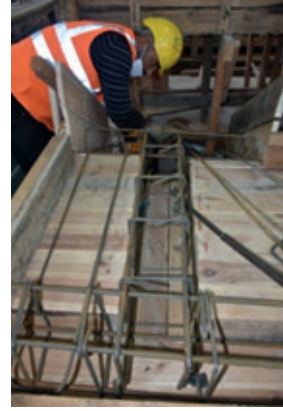
Resim 16.6: Kirişleri kalıba yerleştirme
