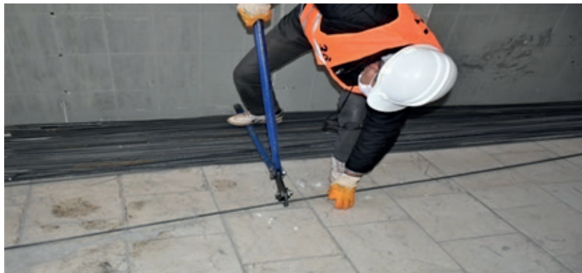
Resim 11.31: Fret donatısı kesimi
