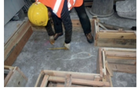
Resim 14.5: Kalıp içine çizim
