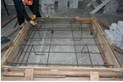
Resim 14.33: Üst demirleri bağlama
