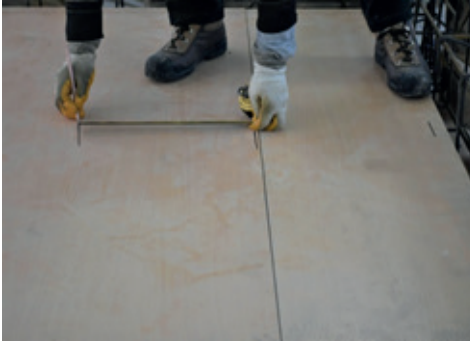
Resim 15.1: Döşeme kalıbı üzerine donatı yerlerinin işaretlenmesi
