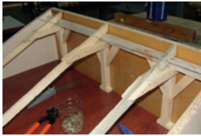
Resim 10.19: Makasların kuşaklarının tamamlanması
