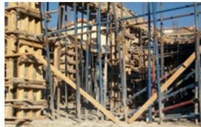
Resim 8.4: Takviyelerin sökümü
