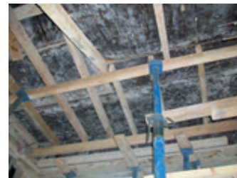
Resim 8.39: Döşeme kirişindeki yedek dikmeler
