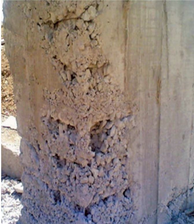
Resim 7.4: Betonda ayrışma
