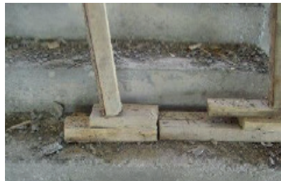
Resim 8.12: Dikmelerin altına yastık konulması
