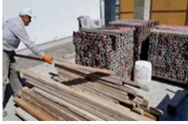
Resim 8.5: Kalıp tahtalarının istiflenmesi
