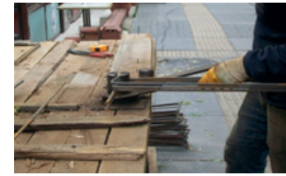
Resim 11.23: Etriye kancası yapımı
