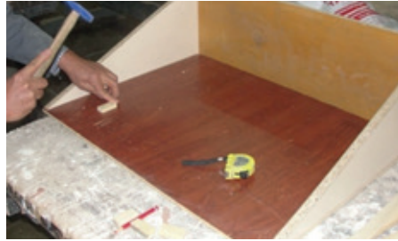
Resim 10.4: Damlalık aşığı yastıklarının çakılması
