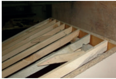
Resim 10.22: Merteklerin mahyaya çakılması
