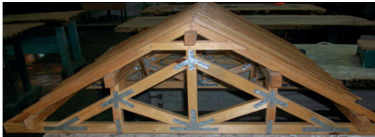
Resim 9.29: Üç dikmeli askılı çatı makası
