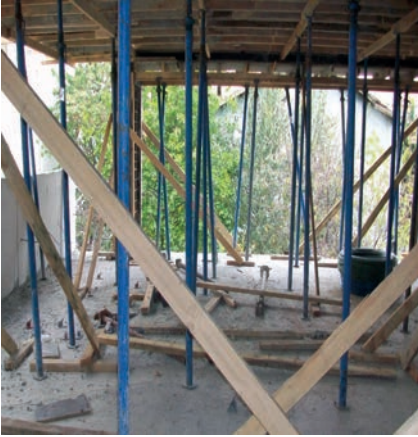
Resim 8.36: Çapraz takviyeler
