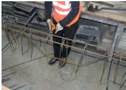
Resim 12.10: Etriye ve pilye demirinin bağlanması
