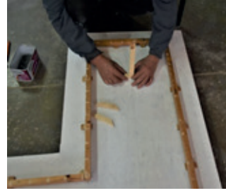
Resim 10.31: Dikme yastıklarının çakılması
