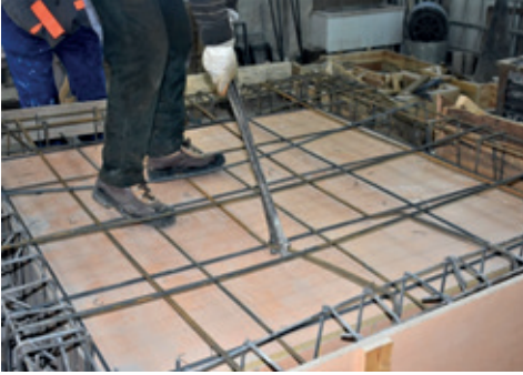
Resim 15.6: Dōřeme pilye bükümü
