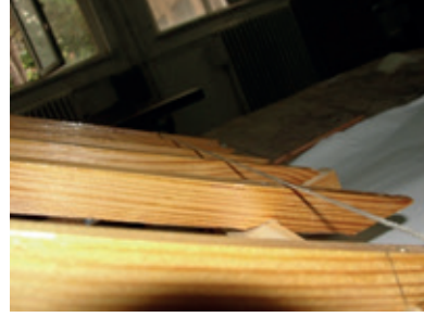
Resim 10.74: Merteklerin ip kotunda çivilenmesi
