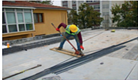
Resim 12.2: Demirlerin kesilmesi
