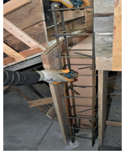
Resim 13.11: Kolon donatısının kalıba yerleştirilmesi
