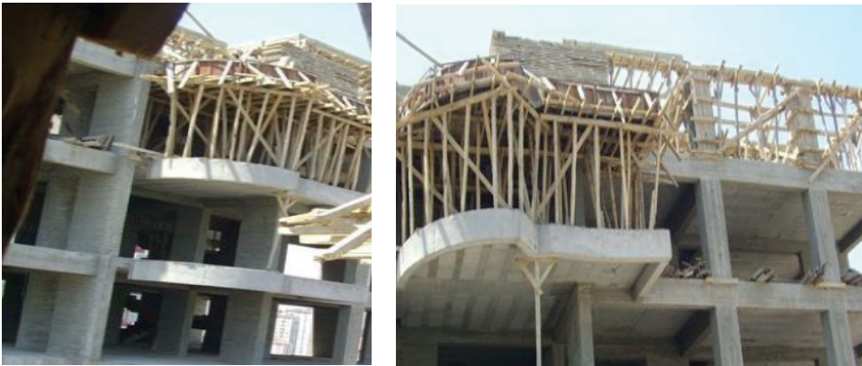
Resim 8.35: Kalıpların katlarda kullanılması
