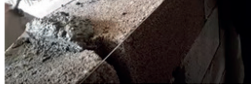
Resim 19.4: Düşey derzlere harç konulması
