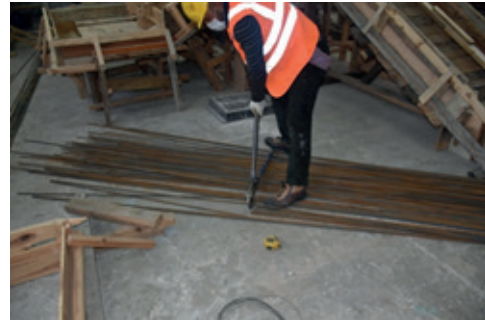
Resim 13.13: Donatı demirlerinin kesilmesi
