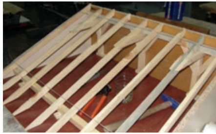
Resim 10.20: Merteklerin kuşaklara çakılması
