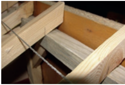
Resim 10.21: Mertek mahya kertmelerinin yapılması
