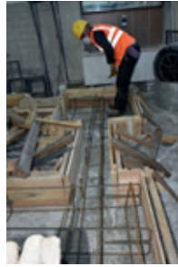
Resim 14.11: Etriye kancalarının montaj şekli
