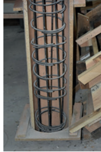
Resim 13.24: Bağlanmış fret donatısı
