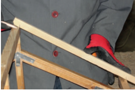
Resim 10.67: Mertekleri kertelemek için markalama
