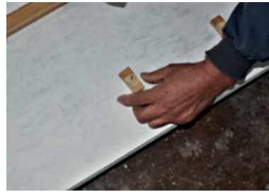
Resim 10.28: Damlalık aşığı yastıklarının çakılması
