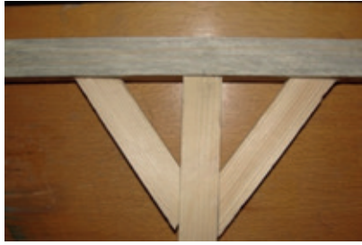
Resim 10.9: Göğüslemelerin çakılması
