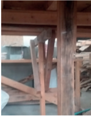
Resim 8.17: Kalıp takviyelerin sökümü
