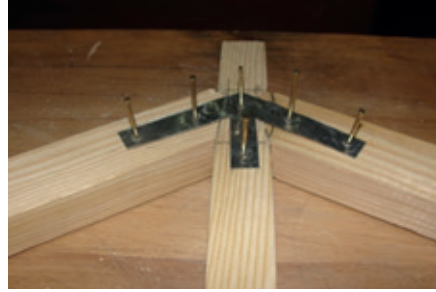
Resim 10.54: Düğüm noktalarının çivilenmesi
