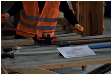
Resim 13.4: Etriye kancasının bükülmesi
