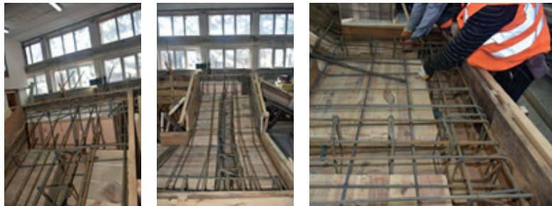
Resim 16.8: Kiriş boyuna donatı ucunu bağlama
