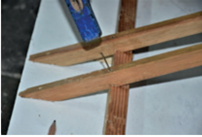
Resim 10.40: Merteklerin çivilenmesi
