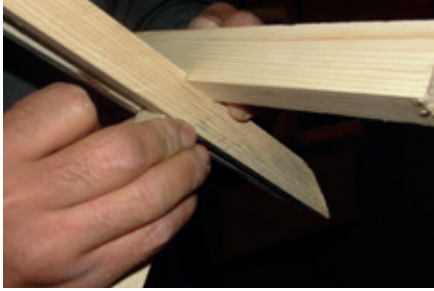
Resim 10.61: Kuşağın dikme ve aşığlara kenetleme
