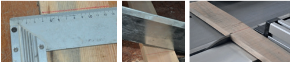
Şekil 2.5: Kalıp elemanlarının markalanıp kesilmesi
