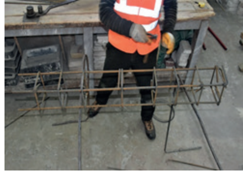
Resim 13.10: Tamamlanmış kolon Etriye ve boyuna donatıları
