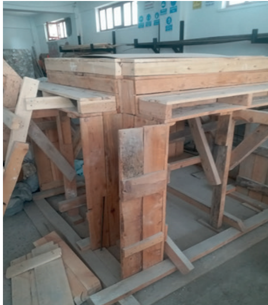
Resim 8.43: Ahşap kalıp
