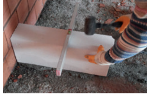
Resim 19.10: Gazbeton blokların yerleştirilmesi
