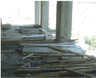
Resim 8.19: Kolon kalıbı malzeme istifi
