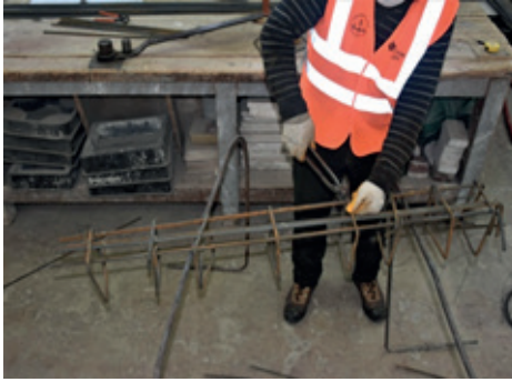
Resim 13.9: Kolon etriyelerinin bağlanması
