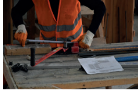
Resim 13.3: Etriynin tezgahta bükülmesi
