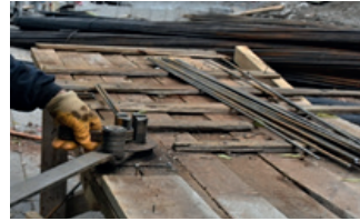
Resim 11.22: Etriyenin bükülmesi
