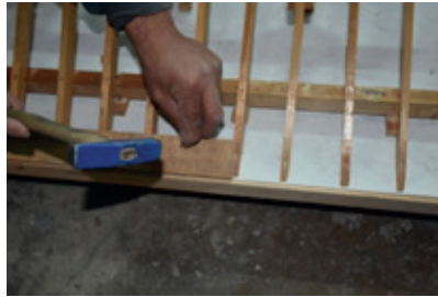
Resim 10.44: Tahta eklerinin mertek ortasına getirilmesi
