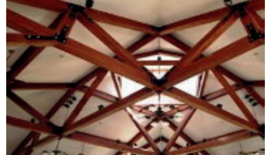
Resim 9.7: Yanlama ile dikmenin bulon ve lama demiri ile bağlantı detayı
