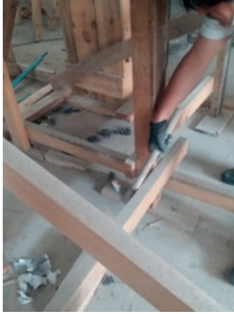
Resim 8.21: Yatayların sökülmesi
