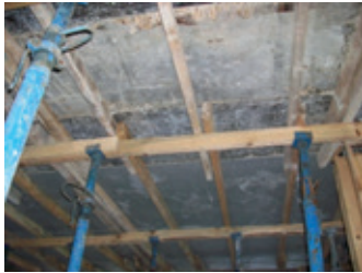
Resim 8.38: Döşeme kirişindeki dikmeler
