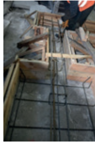
Resim 14.11: Etriye kancalarının montaj şekli
