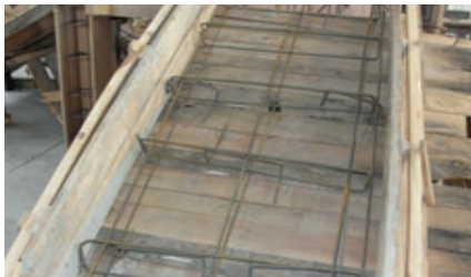
Resim 16.27: Merdiven demirlerinin bağlantılarını kontrol etme
