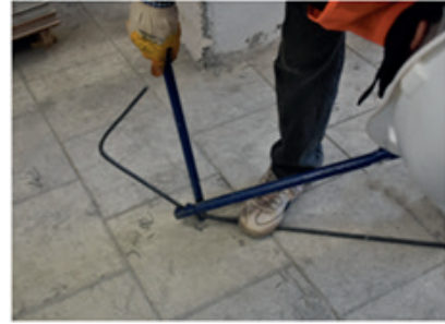
Resim 11.27: Pilye demir çubuğu gönye bükme
