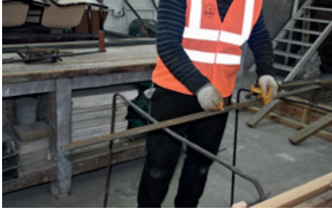
Resim 13.7: Etriye aralıklarının markalanması
