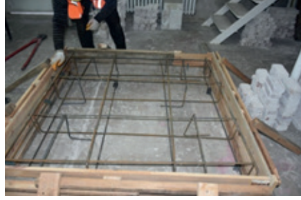
Resim 14.34: Kolon filiz yerlerini markalama
