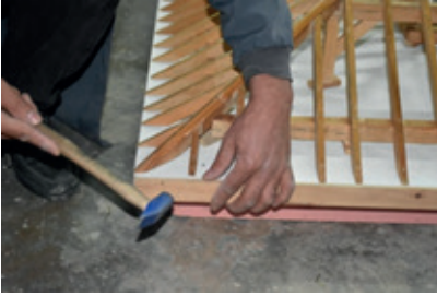
Resim 10.42: Çatı alın tahtasının çakılması
