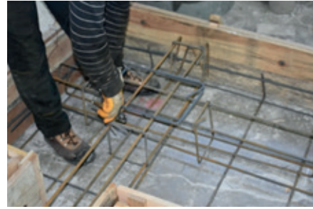
Resim 14.12: Deprem hatlının kolon filizine sarılması
