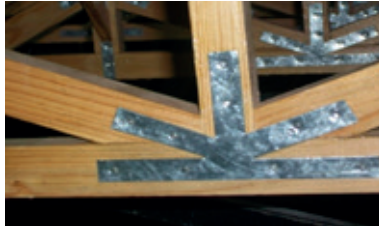
Resim 9.7: Yanlama ile dikmenin bulon ve lama demiri ile bağlantı detayı
