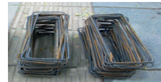
Resim 11.24: Yapımı tamamlanmış etriye donatısı
