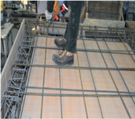
Resim 15.3: Döşeme donatılarının bağlanması
