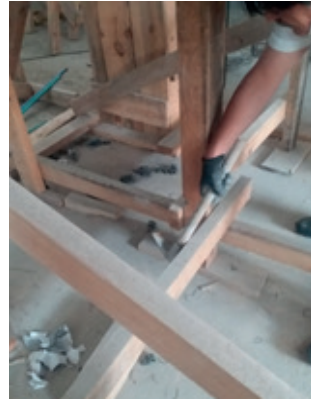
Resim 8.18: Yatay takviyelerin sökümü
