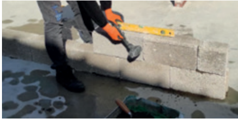
Resim 19.8: Şakul ve su terazisi ile yatay ve düşeylik kontrolü
