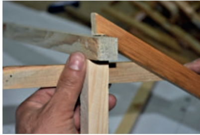
Resim 10.34: Çatı makasının kuşaklarla sabitlenmesi
