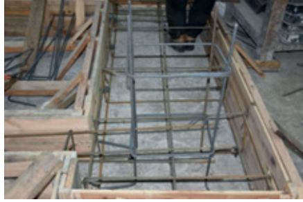
Resim 14.25: Kolon filizlerini bağlama
