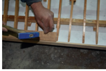
Resim 10.24: Kaplama tahtalarının çakılması
