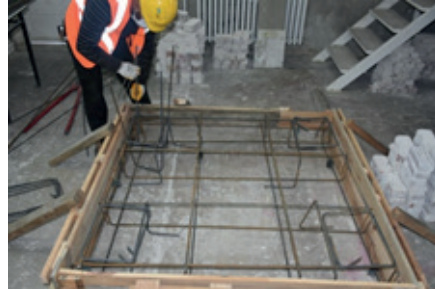
Resim 14.36: Kolon filizleri bağlama
