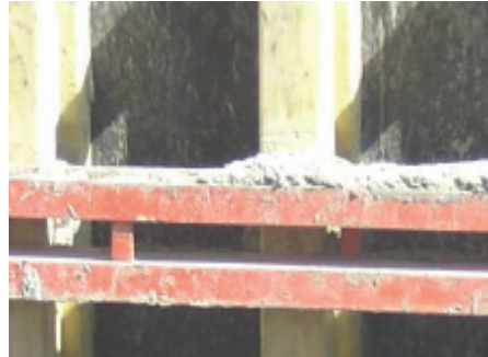
Resim 8.33: Destek profillerinin alınması
