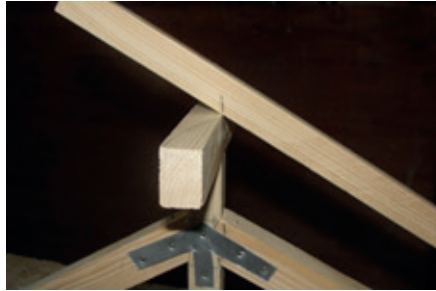
Resim 10.56: Makaslarda mertek markalanması
