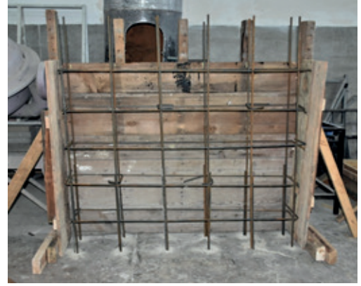
Resim 13.20: Tamamlanmış perde donatısı
