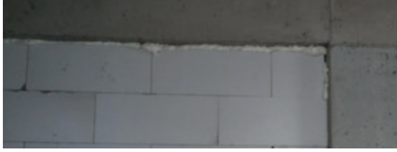
Resim 19.16: Duvar ile kolon/perde birleşim yerindeki boşluğun dolgu malzemesi ile doldurulması
