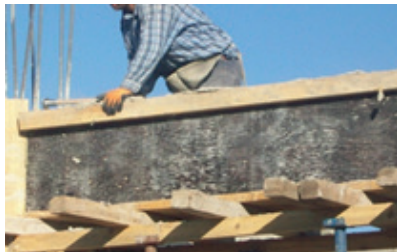
Resim 8.7: Dış kanat takviye sökümü
