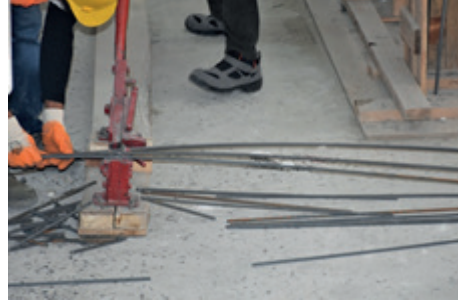
Resim 13.2: Markalanmış demir çubuk kesimi
