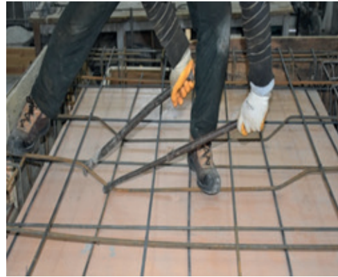
Resim 15.4: Döşeme pilyelerinin bükülmesi
