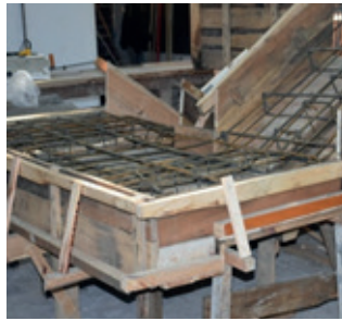
Resim 16.15.a: Donatıların bağlama yerleri
