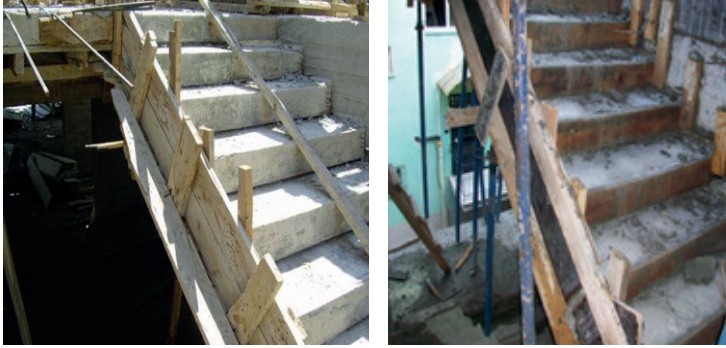
Resim 8.42: Dikmeler, rihtlar ve merdiven kanadı
