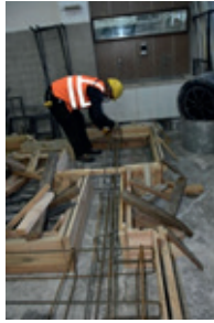
Resim 14.11: Etriye kancalarının montaj şekli
