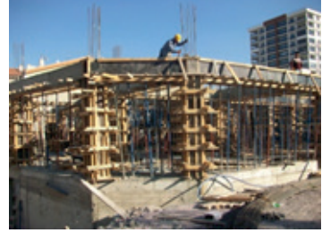
Resim 8.12: Kolon kalıp kanat sökümü
