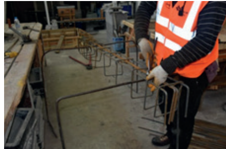
Resim 16.4: Etriye aralıklarını markalama
