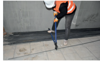
Resim 11.20: Markalanmış demir çubuk kesme
