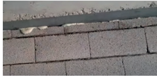
Resim 19.9: Duvar ile kiriş bağlantısının poliüretan köpük ile doldurulması
