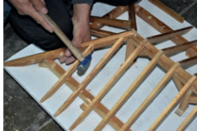
Resim 10.41: Merteğin eğik mahyaya çivilenmesi
