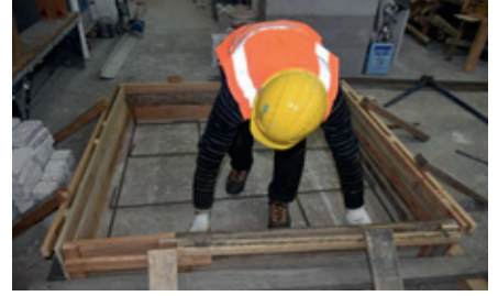
Resim 14.27: Kalıp içinde markalama
