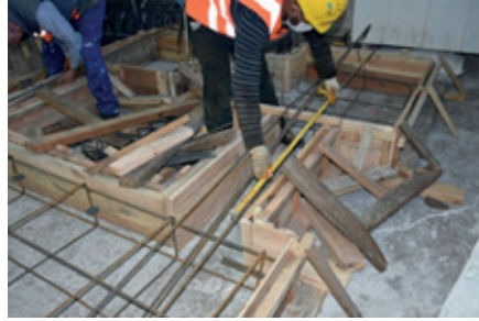
Resim 14.10: Bağ kirişi etriye yerlerini markalama
