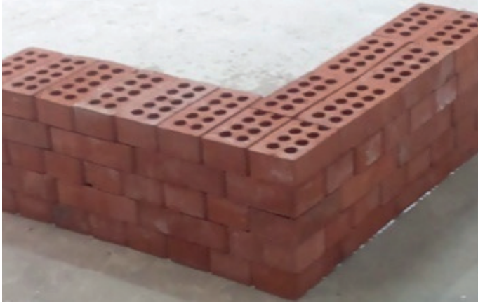
Resim 18.3: Köşede dik birleşen duvar perspektif görünüşü
