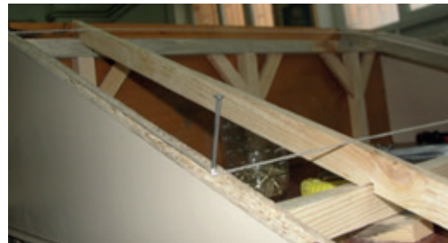
Resim 10.14: Makas merteklerinin kota getirilmesi
