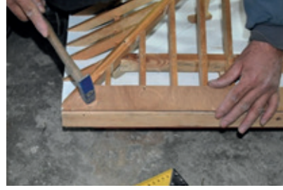
Resim 10.43: Çatı kaplama tahtasının çakılması
