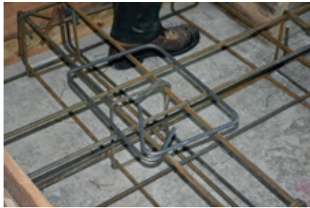
Resim 14.13: Kolon filizlerinin proje aksına bağlanması
