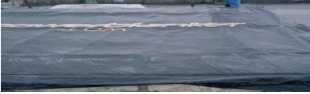
Resim 7.6: Elektrikli ısıtma battaniyesi ile betonun korunması
