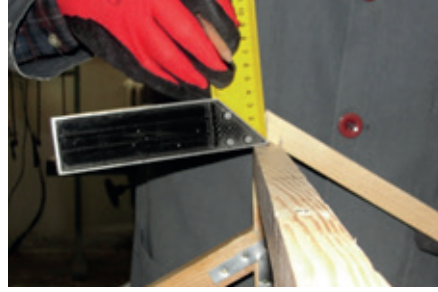
Resim 10.68: Merteklerin mahya aşığı ortasında gönyeli kesimi
