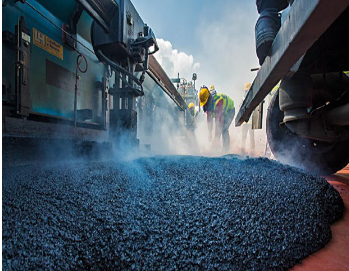
Görsel 9.9: Sıcak bitümlü karışım serme işlemi
