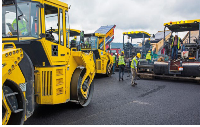
Görsel 9.8: Serme ve sıkıştırma işlerinin birlikte yürütülmesi
