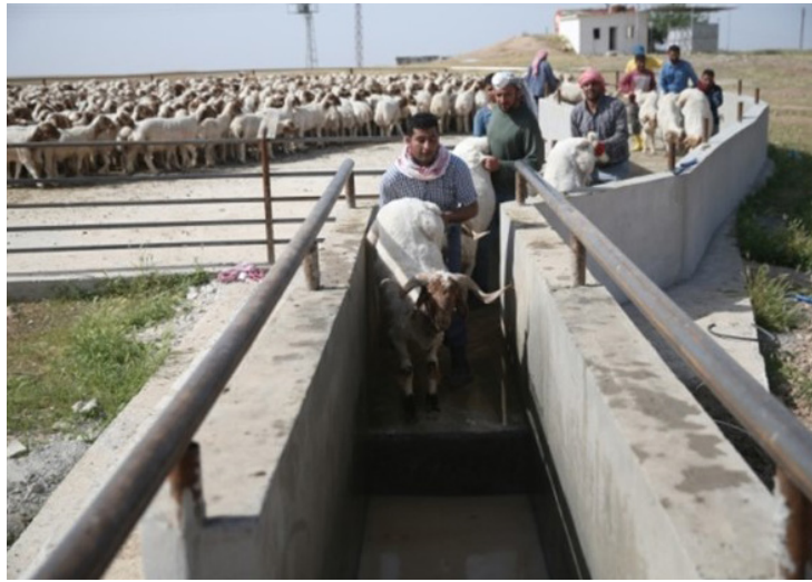
Görsel 8.11: Sabit beton banyoluklar
