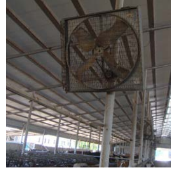
Görsel 4.17: Ahır havalandırması ve serinletilmesinde kullanılan vantilatör
