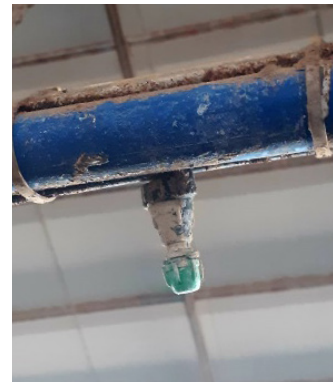
Görsel 4.18: Ahırın serinletilmesinde kullanılan su püskürtücüleri
