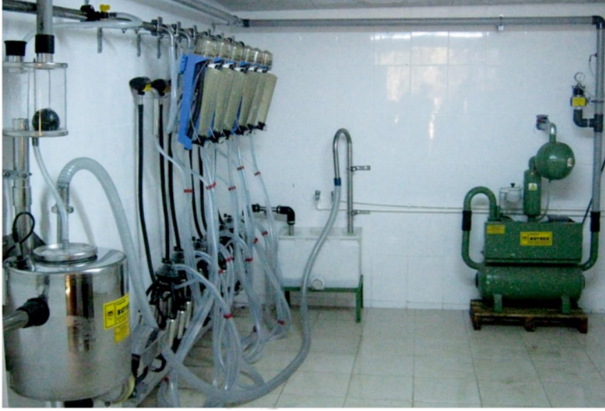
🖼️ Görsel 3.42: Yıkama küvetli COP temizleme sistemi
