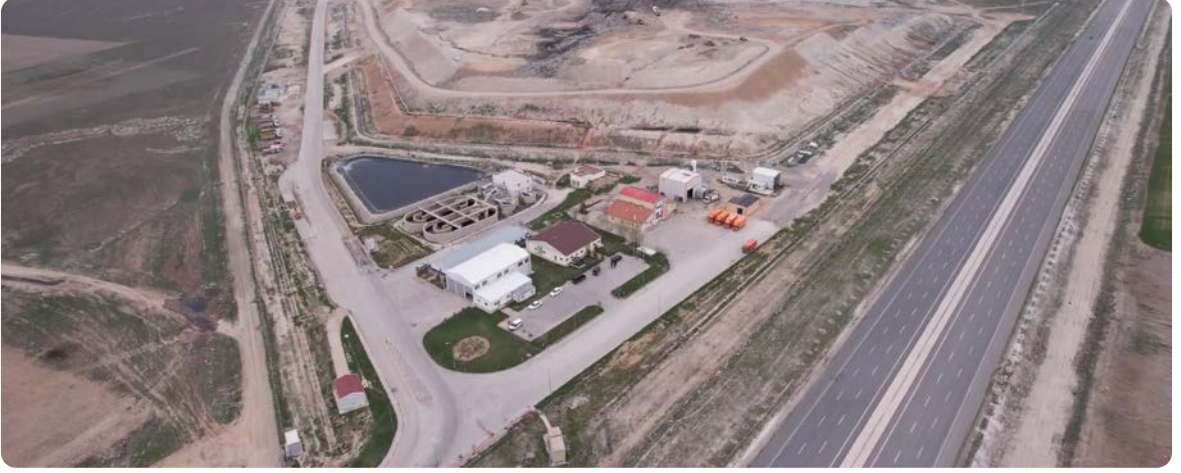
Görsel 1.17: Düzenli depolama tesisi
