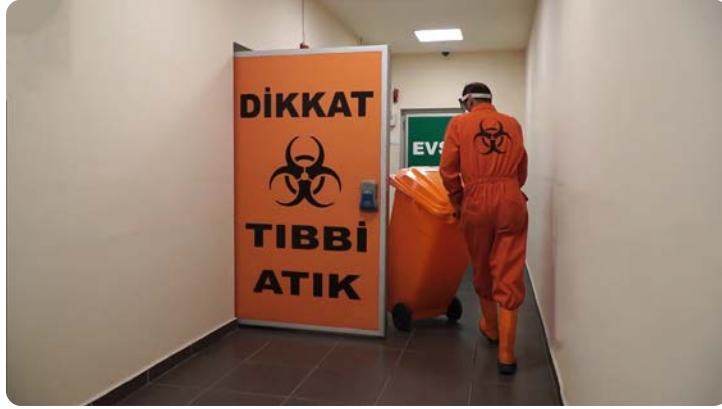
Görsel 1.13: Tıbbi atık geçici deposu
