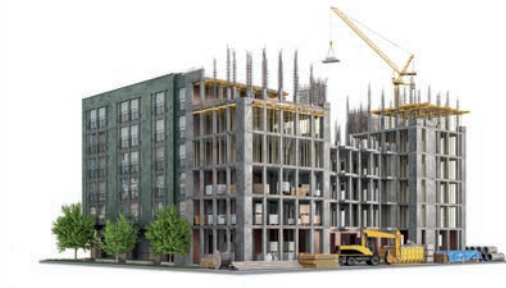
Görsel 7.3: Yüklenicinin inşaatı
