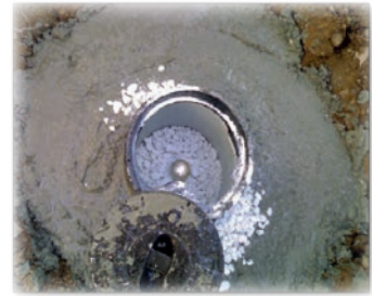
Görsel 1.38: Yer altı nivelman noktalarının tesisi
