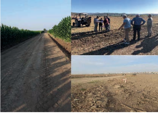
Görsel 3.17: Yer teslimi ve yolların yapımı
