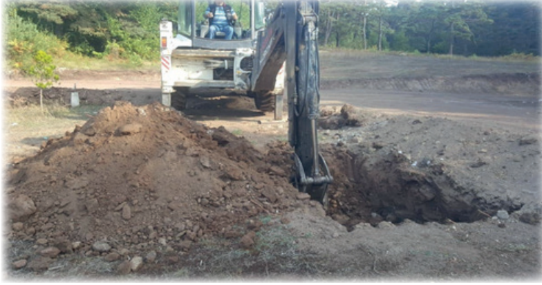
Görsel 2.1: İnşaat temeli için eşilen çukurdan çıkan hafriyat
