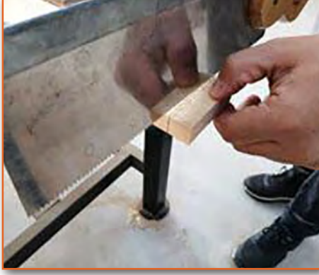
Görsel 3.44: İş parçasının fire kısmına iz yapılması
