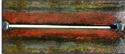
Görsel 6.17: Puntalanan iki parçanın arasındaki mesafe
