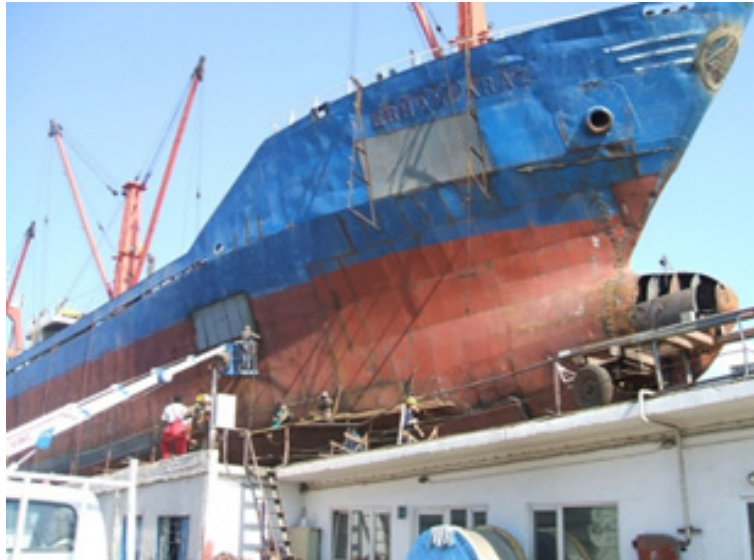
Görsel 3.23: Fazlalıkların temizlenmesi
