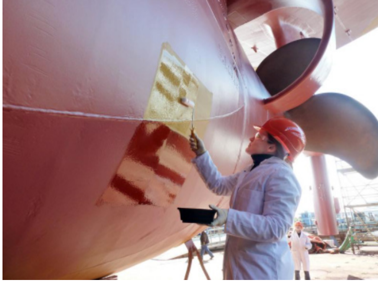
Görsel 8.44: Rulo ile boya uygulaması
