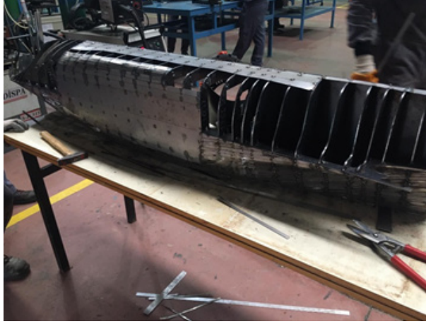
Görsel 3.26: Kaplamanın yapılması I
