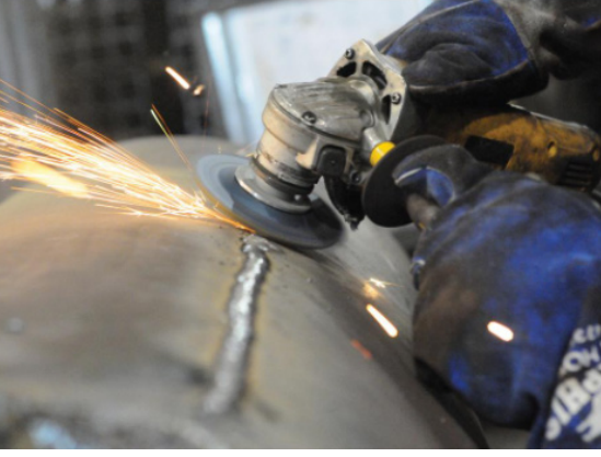
Görsel 8.13: a) Taşlama yöntemi ile yüzey temizleme
