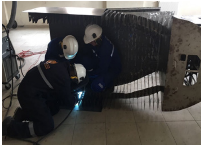
Görsel 3.25: Orta blok kaplaması
