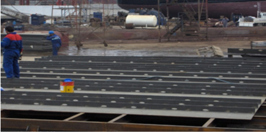
Görsel 1.12: Tank top sacı üzerindeki Hollanda profilleri
