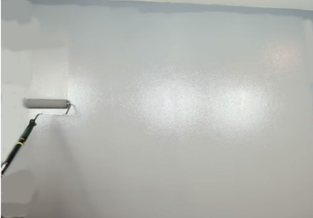
Görsel 8.47: Boyanın rulo ile yüzeye sürülmesi
