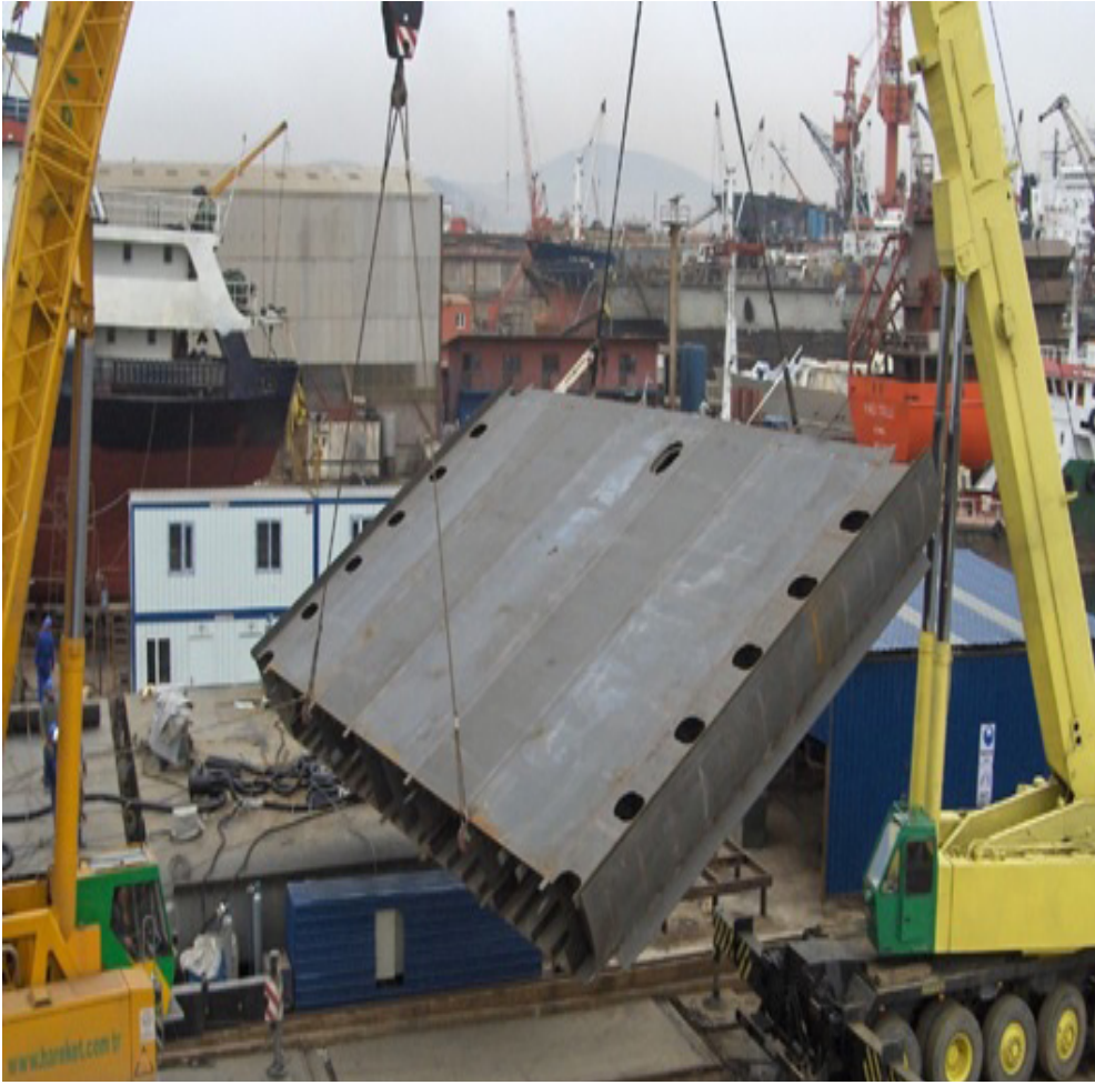
Görsel 1.17: Double bottom tankının ters çevrilmesi
