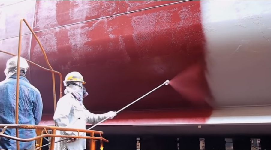
Görsel 8.22: Ara kat boya uygulaması
