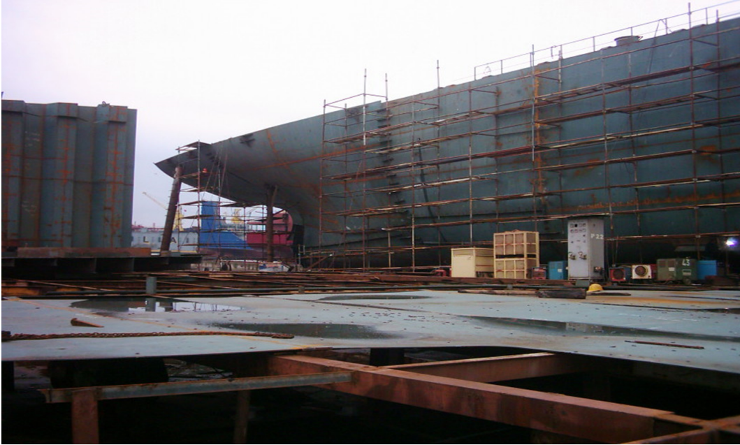
Görsel 3.21: Orta blok kaplaması
