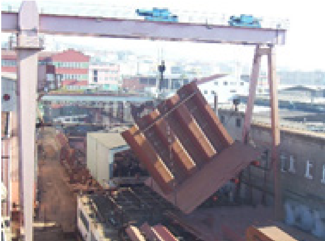
Görsel 3.8: Ondüle perde uygulaması II
