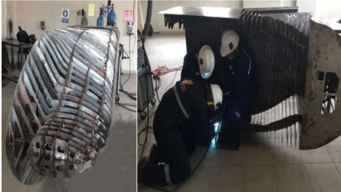
Görsel 3.29: Örnek orta blok montajı ve kaplaması
