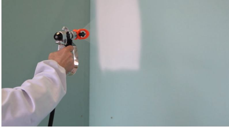
Görsel 8.36: Havalı sprej uygulama
