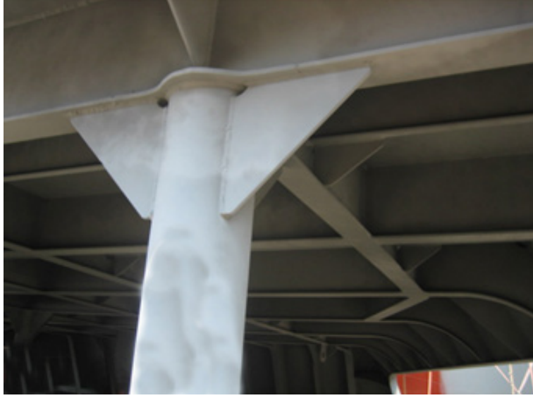
Görsel 3.5: Gemi güvertesi altında dikme (puntel) uygulaması
