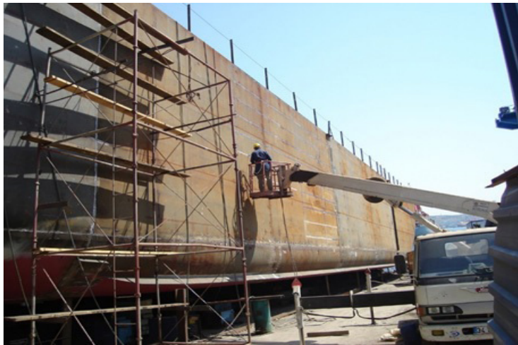
Görsel 3.22: Orta blok kaplaması
