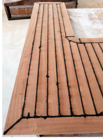
Görsel 6.5: Güverte kaplamasına sika uygulaması
