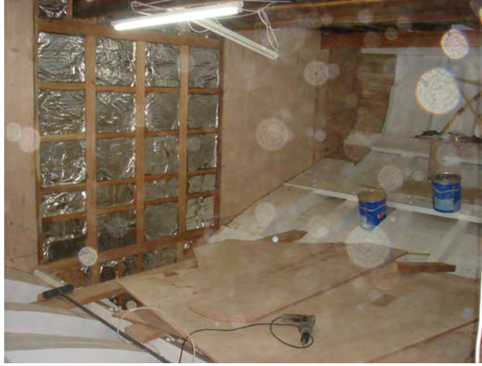
Görsel 8.12: Kamara duvar karkaslarının izolasyonu
