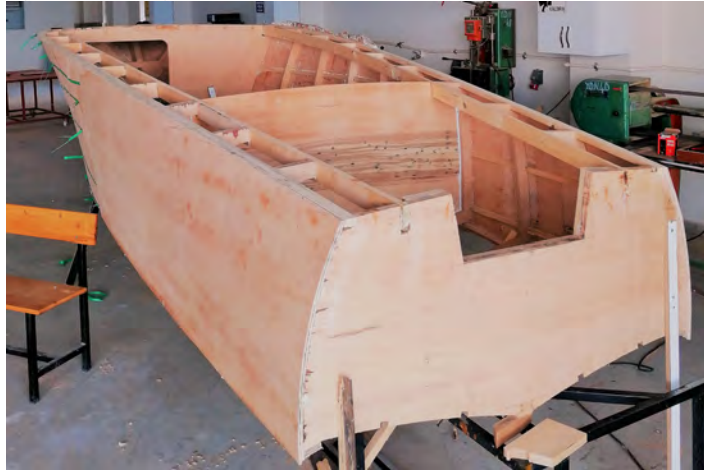
Görsel 5.13: Su kontrplağı ile kaplama
