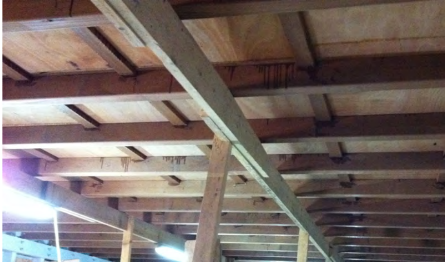
Görsel 4.4: Tülanilerin montajı
