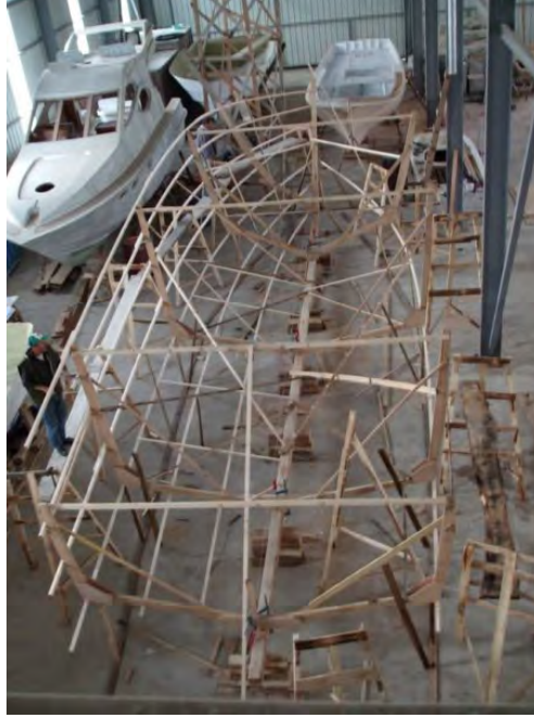
Görsel 2.8: Posta formalarının çekilmesi
