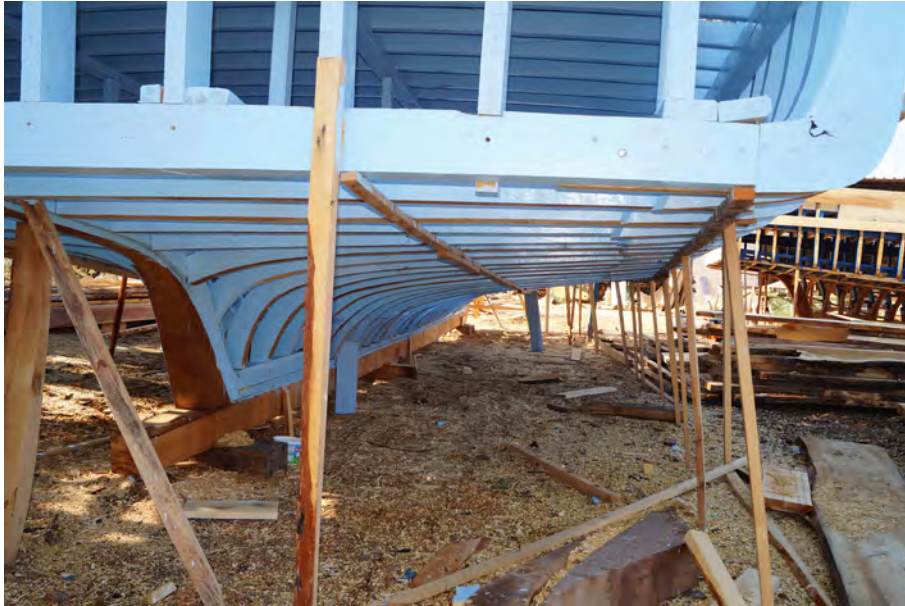
Görsel 3.4: Form çıtalarının montajı
