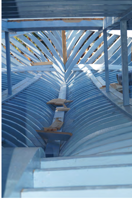
Görsel 2.24: Ahşap Sotroponun tekne içinden görünüşü
