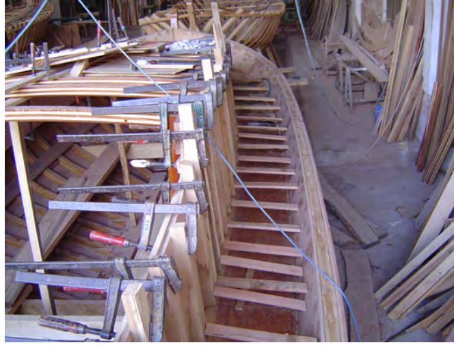
Görsel 8.4: Kamara yan duvarının yapılması
