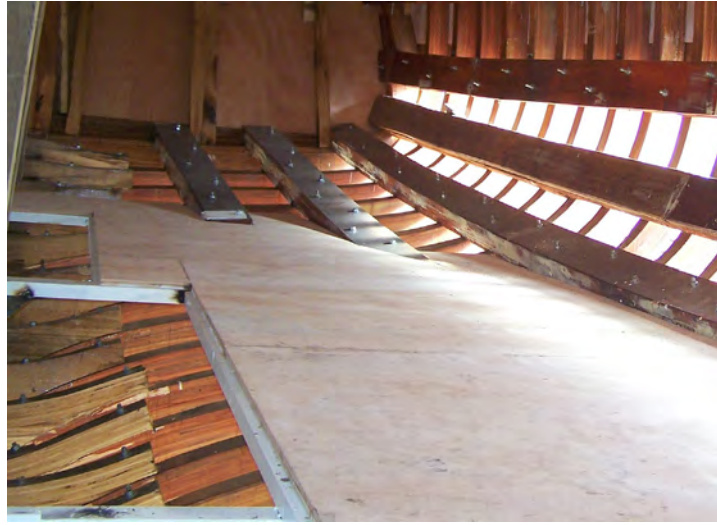
Görsel 4.14: Farşların montajı
