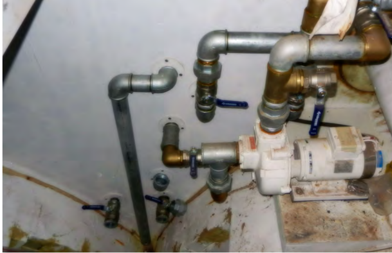
Görsel 4.6: Su geçirmez perde tesisat izolasyonu
