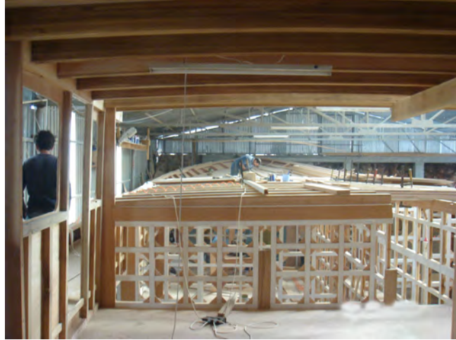
Görsel 8.10: Kamara dış duvar karkasları
