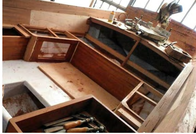
Görsel 9.3: Havuzluk inşası
