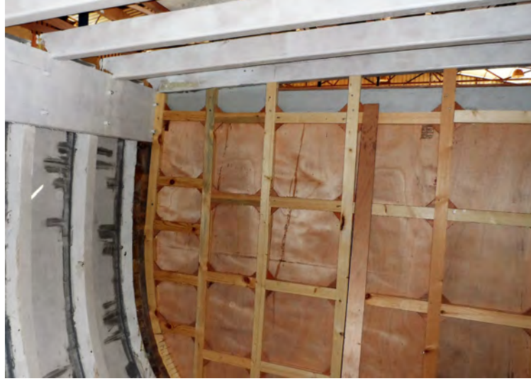
Görsel 4.7: Su geçirmez perde karkası
