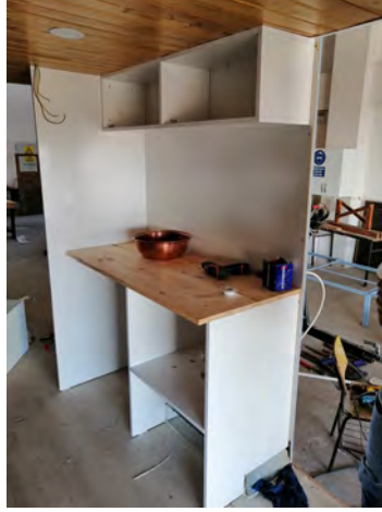
Görsel 10.6: Mutfak mobilyalarının montajının yapılması
