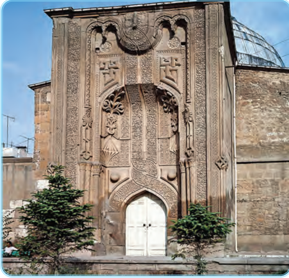
Görsel 3.39: Konya İnce Minareli Medrese, Taç kapısı
