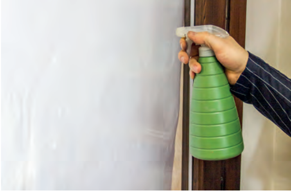
Görsel 1.53: Cam yüzeye su püskürtme
