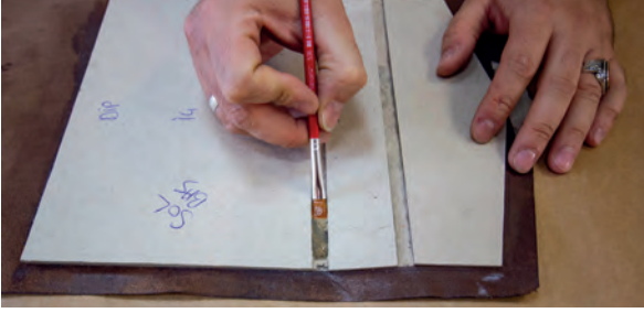
Görsel 3.63: Çıkartılan çıta yerlerinin ıslatılması
