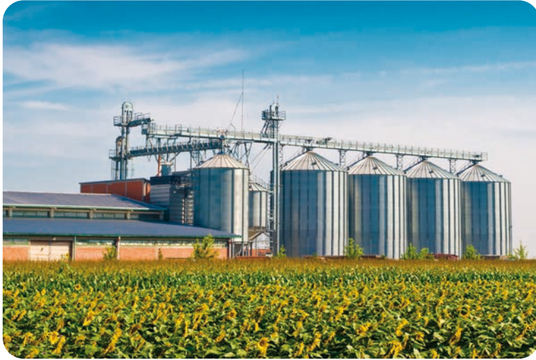
Görsel 1.38: Tarım ürünü silosu
