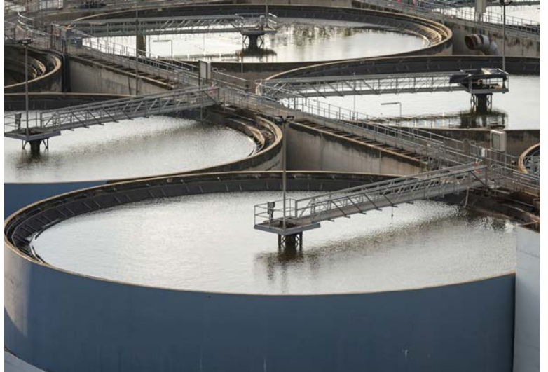
Görsel 3.5: Atıksu arıtma tesisi
