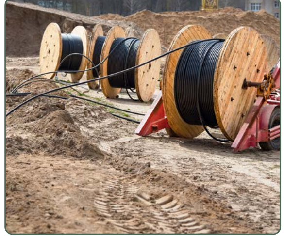
Görsel 6.3: Yer altı kablolarının döşenmesi
