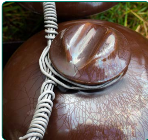
Görsel 5.45: İzolatöre iletken bağlantısı
