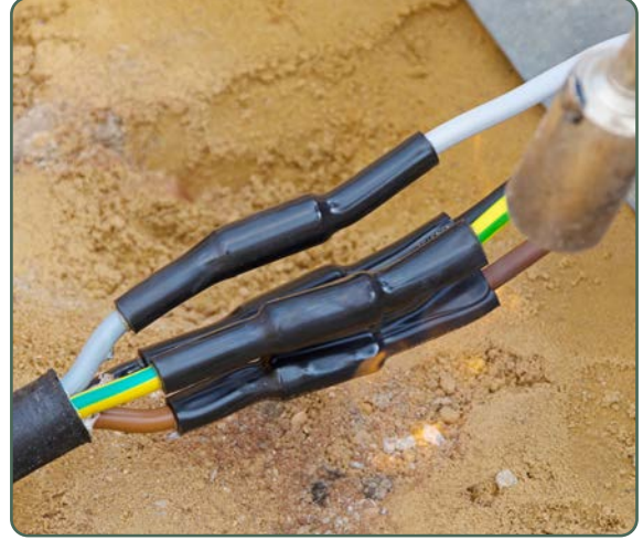
Görsel 6.4: Yer altı kablosunun eklenmesi
