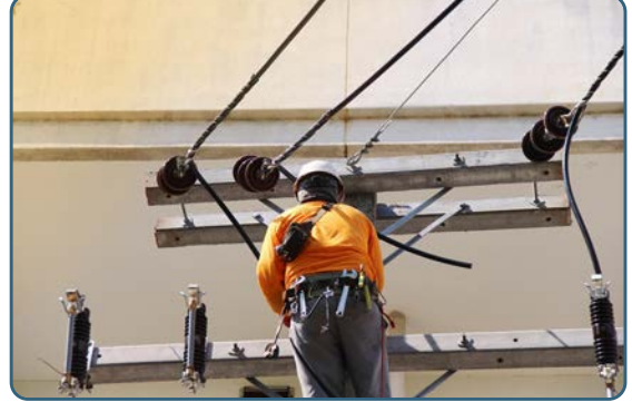
Görsel 3.10: Ayırıcı montajı
