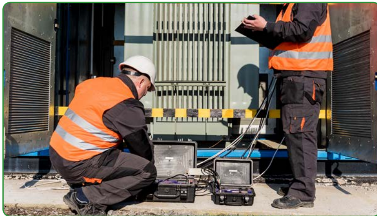
Görsel 2.8: Trafo bakımı
