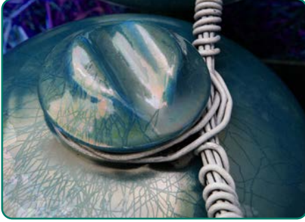
Görsel 5.46: İzolatöre iletken bağlantısı
