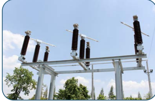
Görsel 3.5: Döner izolatörlü ayırıcı
