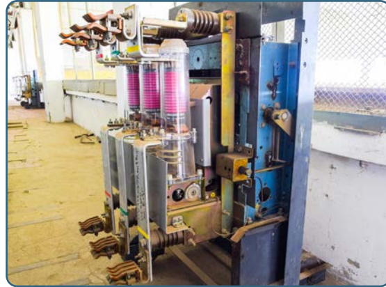
Görsel 3.8: Vakumlu tip kesici
