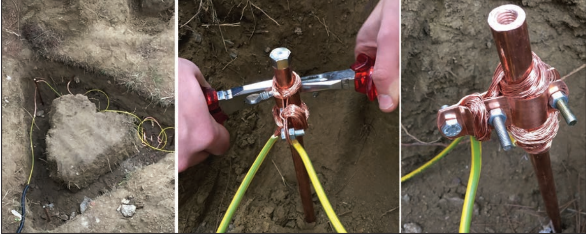
Görsel 2.63: Topraklama çubuğunun montajı ve toprak hattı kablosunun bağlanması
