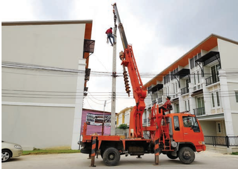
Görsel 7.15: Aydınlatma direęinin dikilmesi
