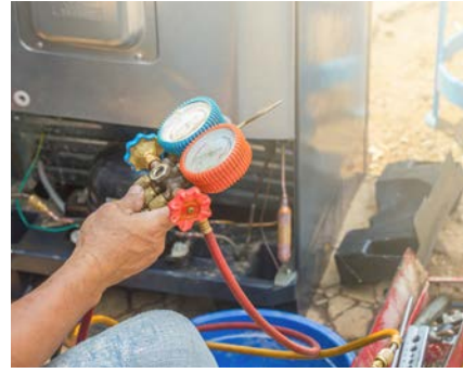
Görsel 2.24: Manifold ile ölçüm yapma işlemi
