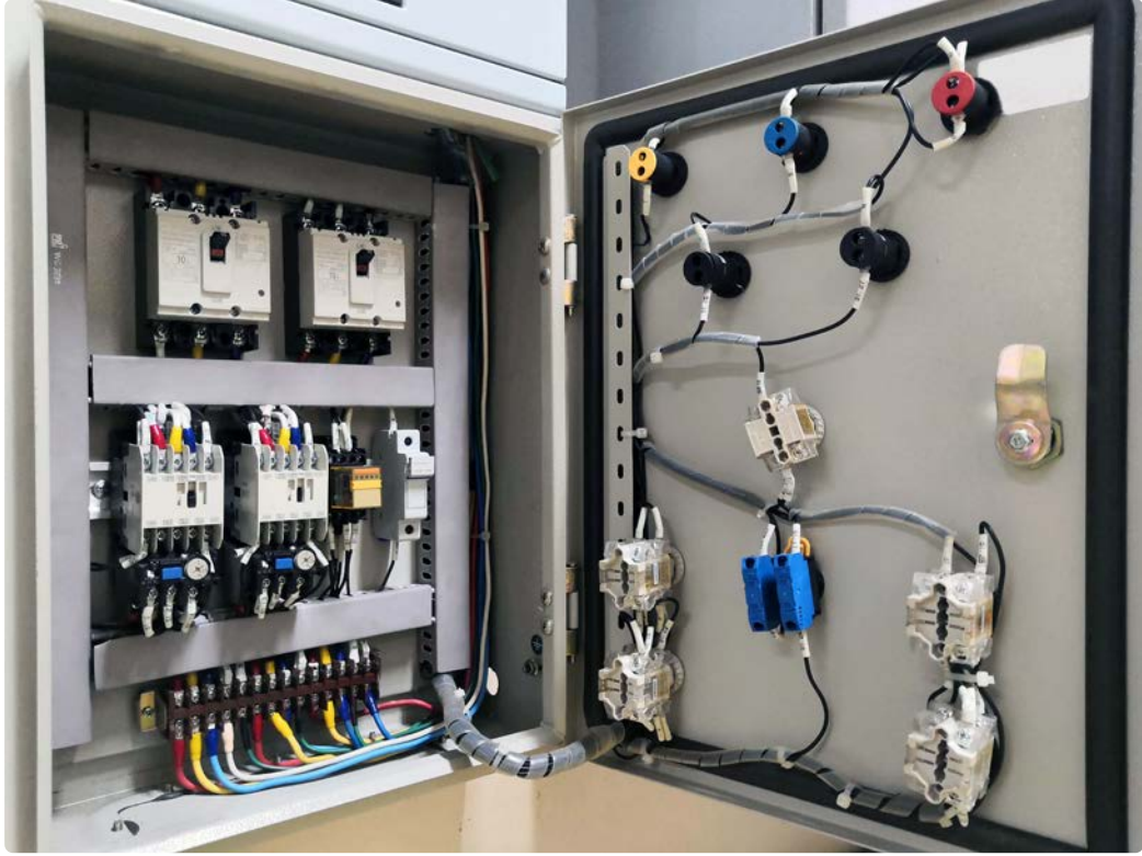
Görsel 1.39: Kumanda devre elemanlarının montajı
