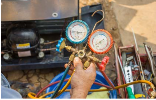
Görsel 2.24: Manifold ile ölçüm yapma işlemi
