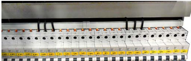
Görsel 8.20: Sigorta barası montajı ve kablo bağlantıları
