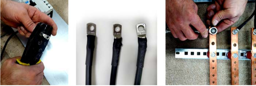
Görsel 8.31: Dağıtım panosunda baralara kablo bağlantısı yapma
