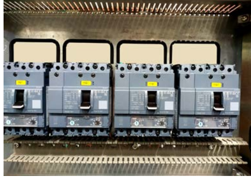
Görsel 8.16: Termik manyetik şalter montajı
