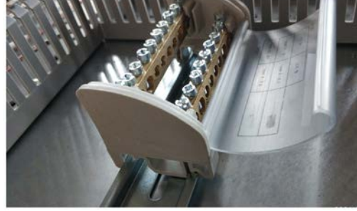
Görsel 1.21: Ray klemenslerinin ve modüler enerji dağıtım baralarının montajı
