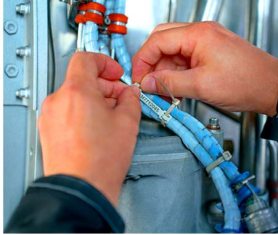
Görsel 2.22: Kabloların kablo bağı ve spiralle düzenlenmesi
