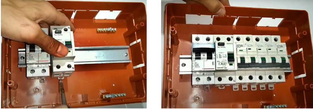
Görsel 8.19: Kaçak akım rölesinin ve sigortaların raya montajı
