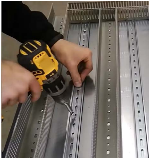
Görsel 1.11: Matkap uçlu vida ile kanal ve ray montajı
