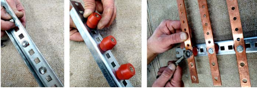
Görsel 8.9: Mesnet izolatörü ve baranın montajı
