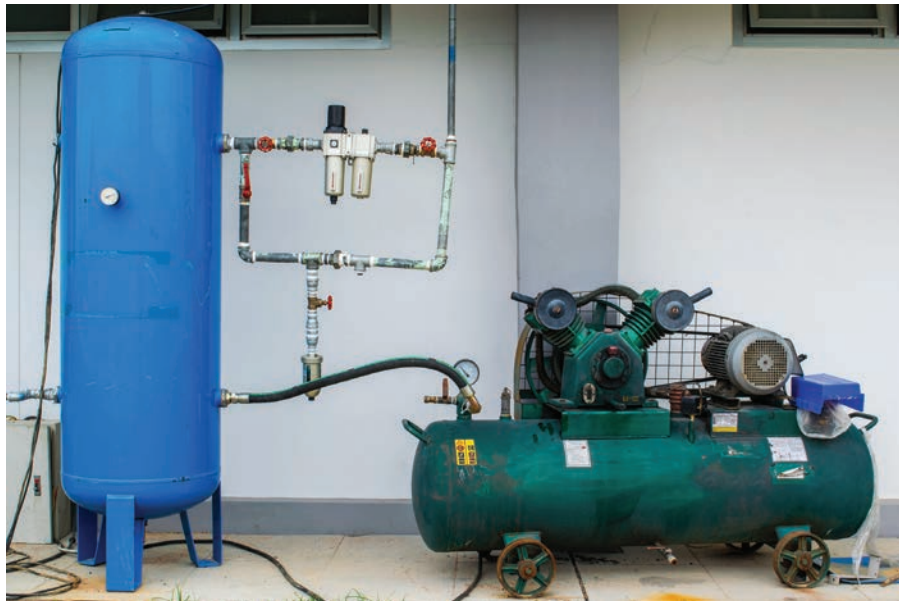
Görsel 4.3: Basınçlı hava tankı ve kompresör
