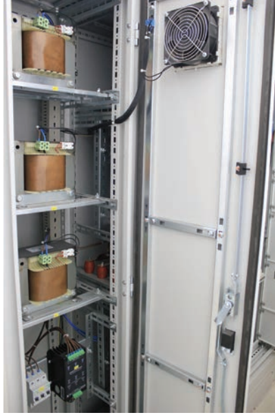
Görsel 11.8: Kompanzasyon panolarında reaktörler ve reaktör sürücüsü
