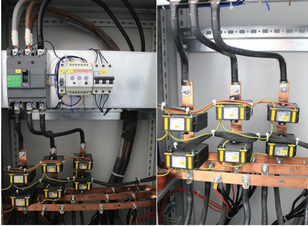
Görsel 11.10: Kompanzasyon panolarında akım trafolarının montajı
