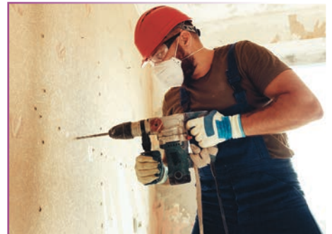
Görsel 2.31: Matkapla duvar delme işlemi
