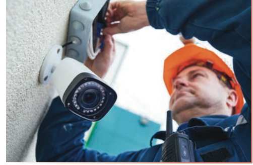
Görsel 3.47: Güvenlik kamerasının kurulumu
