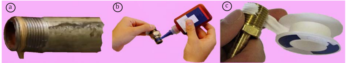
Görsel 9.33: Dişli bağlantıda sızdırmazlık malzemelerinin kullanımı
