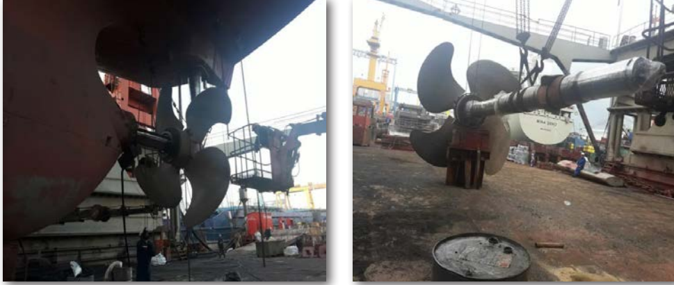
Görsel 5.10: Kanatlı bir pervanenin ve şaftının gemiden sökülmesi
