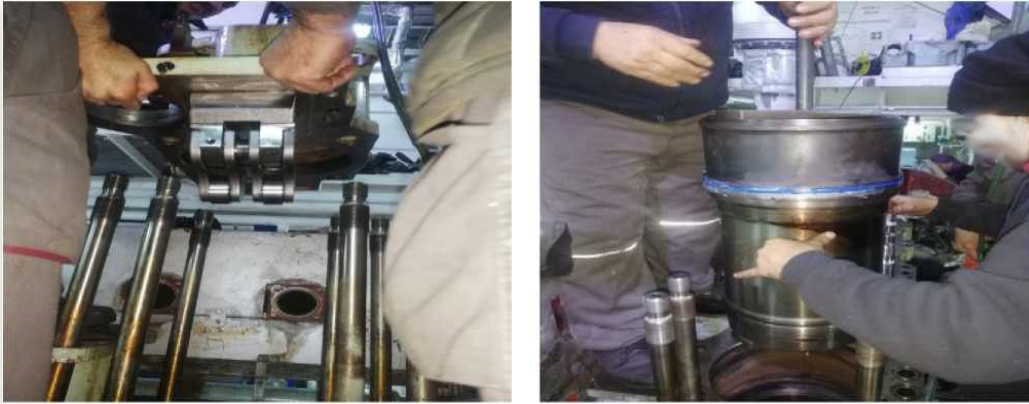
Görsel 3.30: Laynerin su ceketlerinin temizlenmesi ve laynerin yerine takılması
