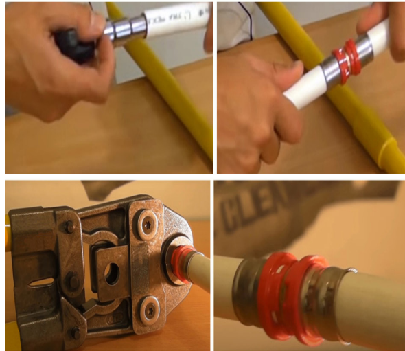
Görsel 9.9: Polietilen boruların presli birleştirilmesi
