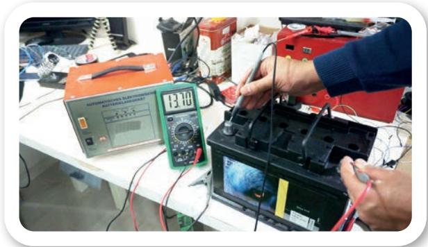
Görsel 18.13: Akü voltajının avometre ile ölçülmesi
