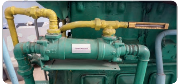
Görsel 15.9: Plakalı ve borulu tip yağ kuleri
