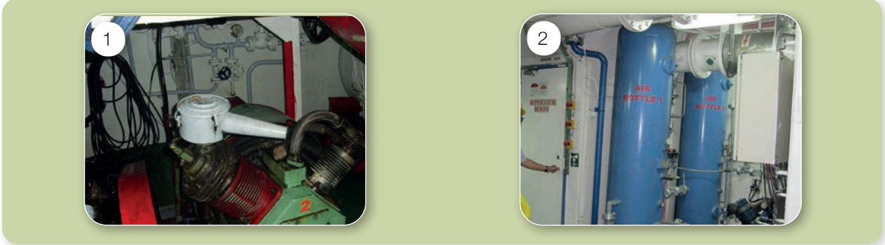
Görsel 15.19: Kompresör ve hava tankı bakımı
