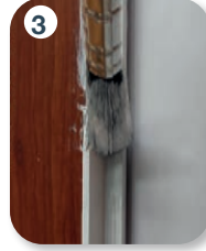
Görsel 5.15: Ahşap yüzeyde raspa boya yapma aşamaları
