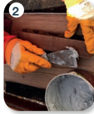
Görsel 5.15: Ahşap yüzeyde raspa boya yapma aşamaları
