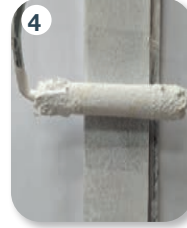
Görsel 5.15: Ahşap yüzeyde raspa boya yapma aşamaları
