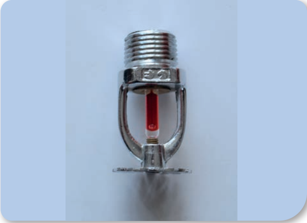
Görsel 3.16: Kapalı tip sprinkler nozulu
