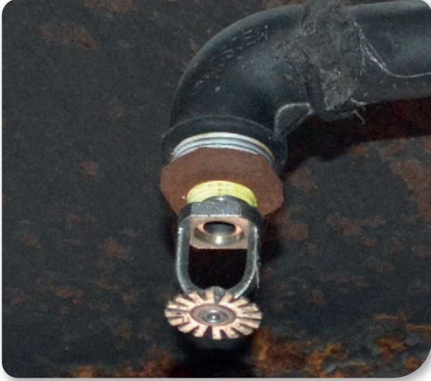
Görsel 3.15: Açık tip sprinkler nozulu
