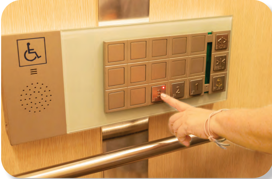
Görsel 4.4: Görme yetersizliği olan bireyler için hazırlanmış asansör düğmeleri
