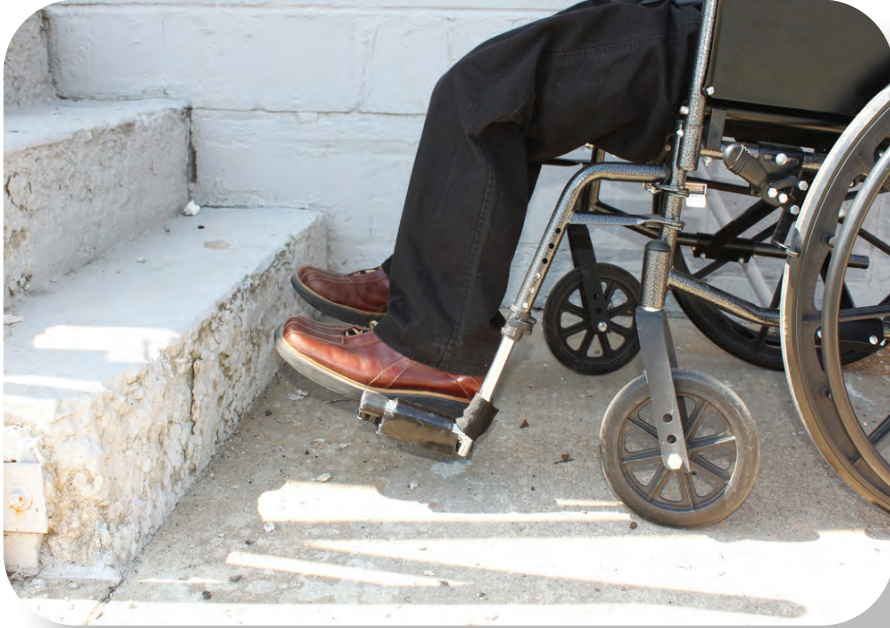
Görsel 4.6: Merdiven engeli
