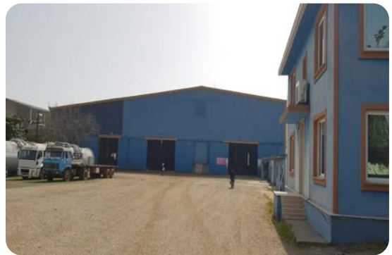
Görsel 1.3: Depo ve idari hizmet binası
