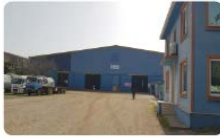
Görsel 1.3: Depo ve idari hizmet binası
