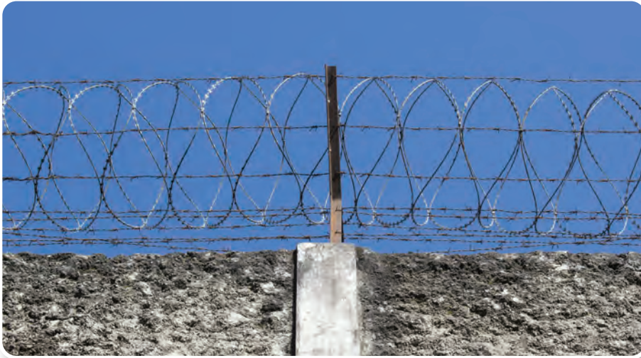
Görsel 4.26: İhata duvarı üzerindeki jiletli teller
