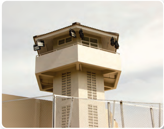
Görsel 4.40: Cezaevi dış duvarı ve gözetleme kulesi
