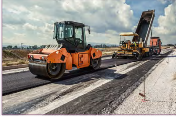
Görsel 1.58: Yol yapım çalışması
