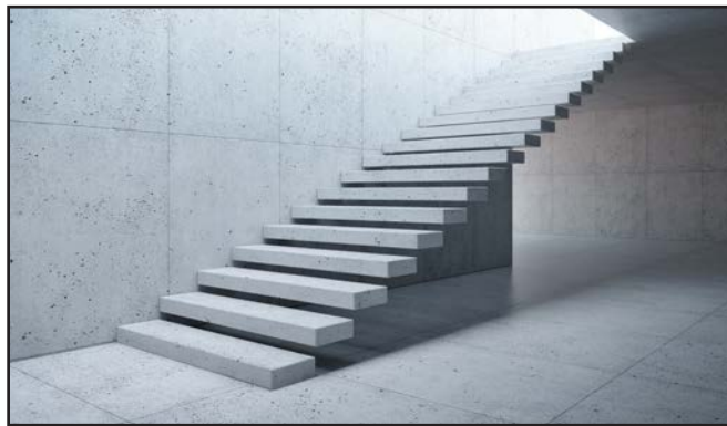
Görsel 3.16: Merdiven arasındaki boşluklar
