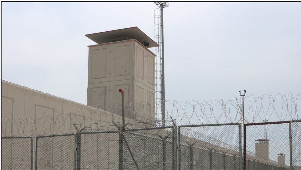
Görsel 3.4: Çatıda nöbet kulesi bulunan ceza infaz kurumu
