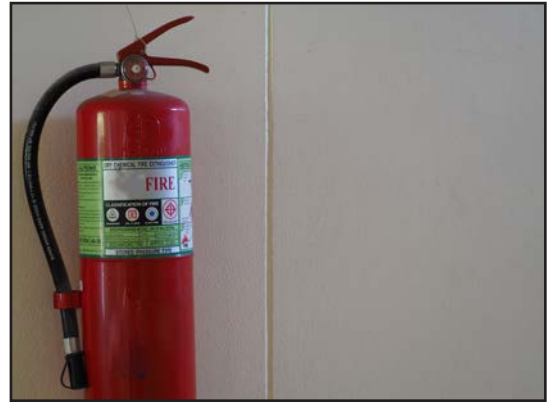
Görsel 1.8: Kimyevi kuru tozlu yangın söndürme tüpü
